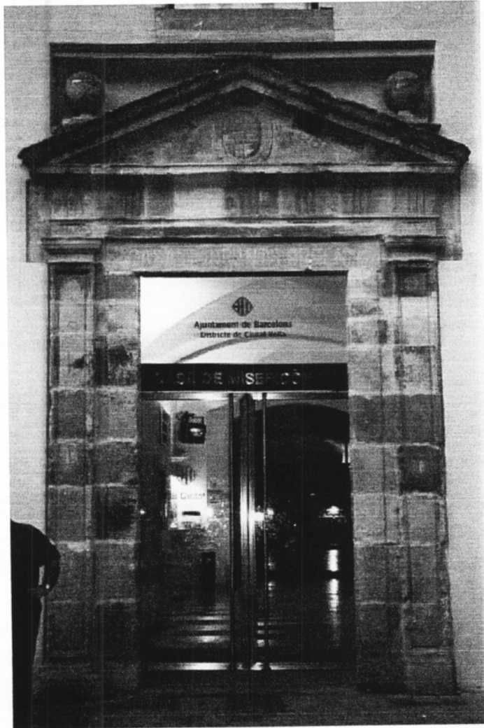
Imatge 1. Portalada de la Casa de la Misericòrdia, just davant de la zona d'intervenció arqueològica
