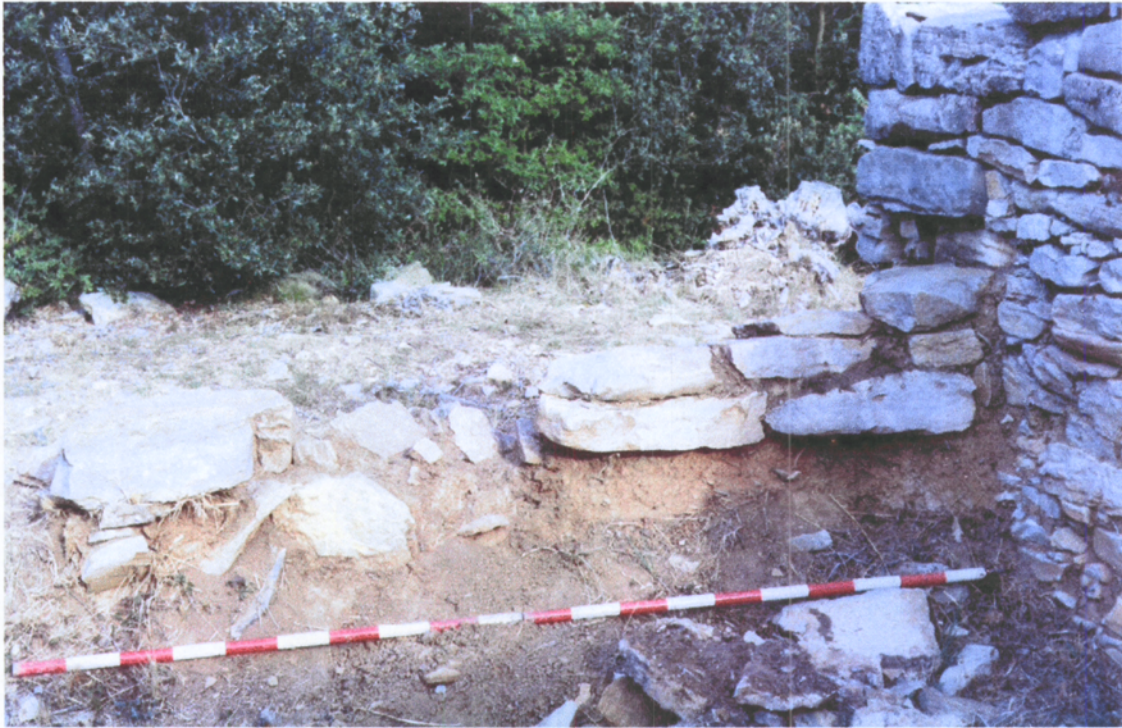
5. Vista interna del parament del mur de tancament de l'àmbit 3, fase moderna.
