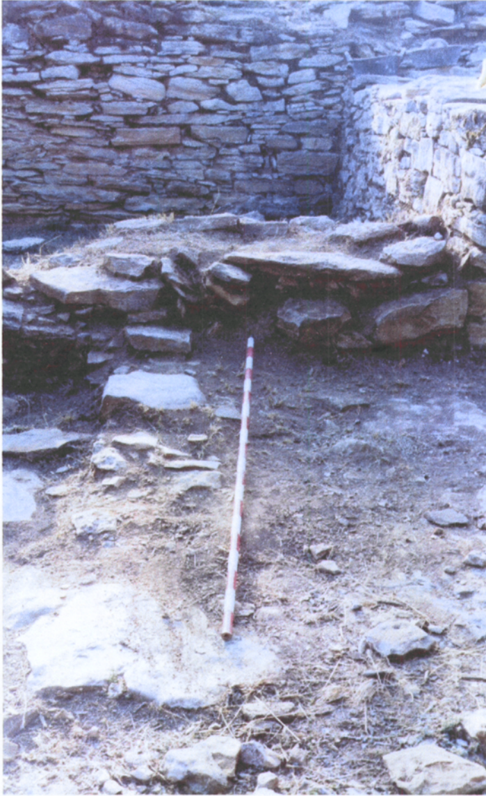
4. Àmbit 3'. Detall del mur lateral que tancava El pati
