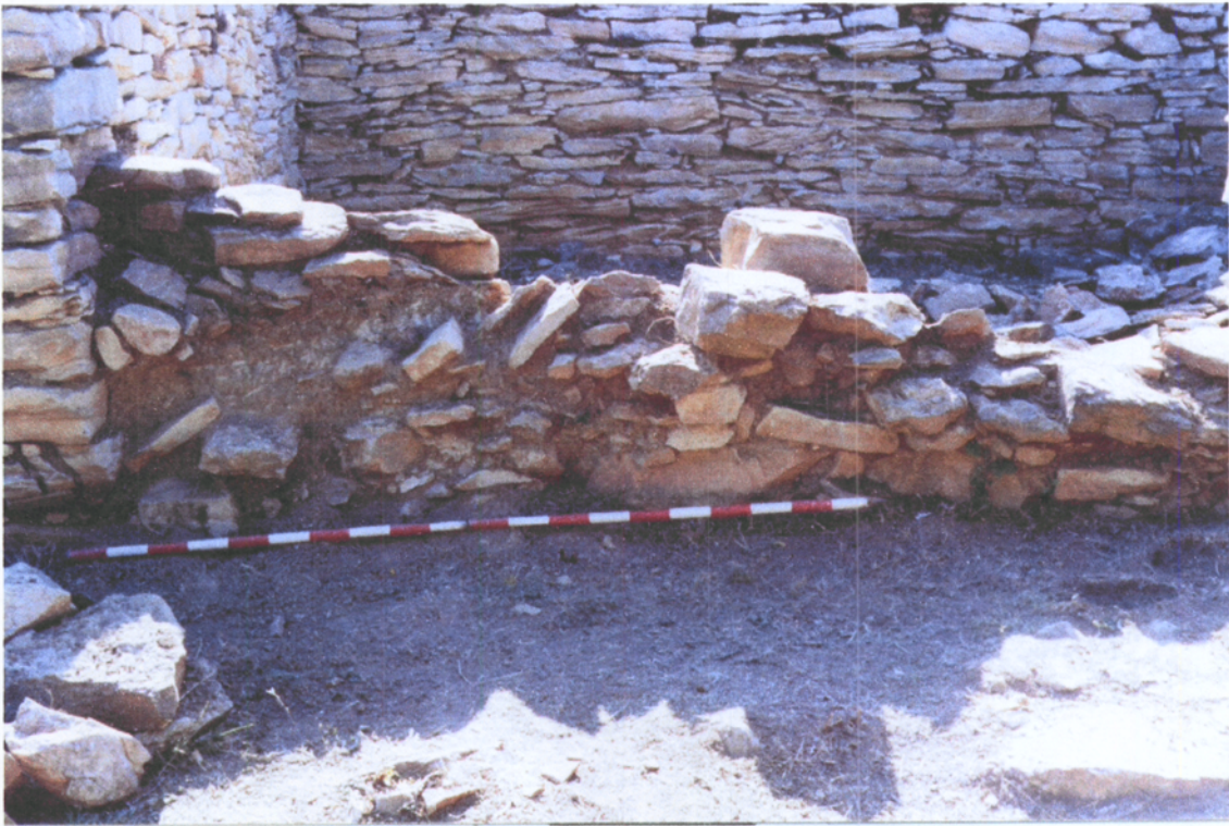
3. Àmbit 3. Mur de tancament de la fase més moderna.
