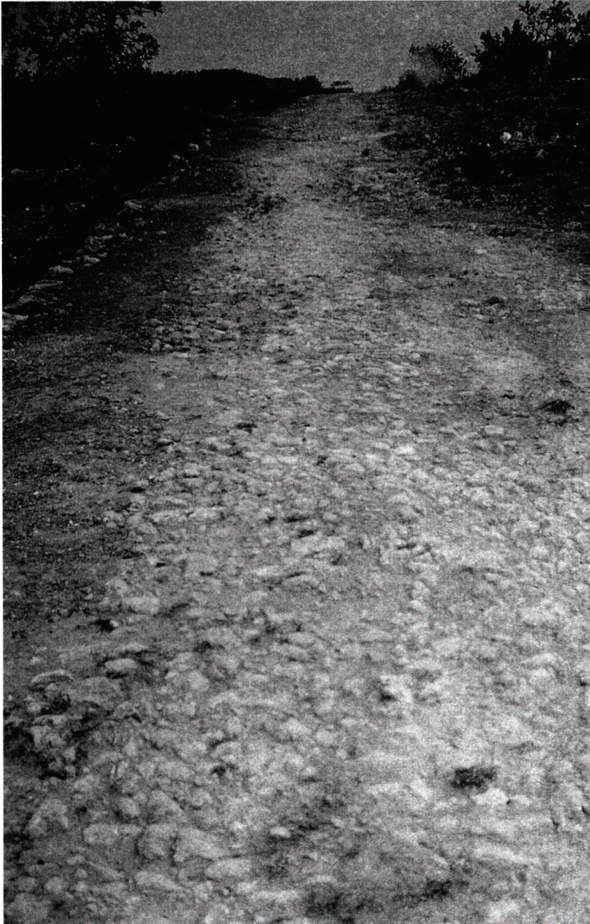
Fig. 1. Vista d'un sector del tram de la Via Augusta, al Perelló, que conserva la pavimentació de còdols lligats amb morter.
