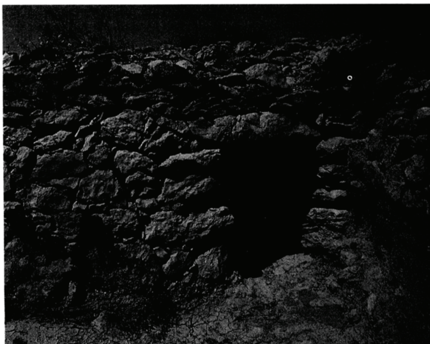
Fig. 2. Mur lateral de la via travessat per una claveguera.
