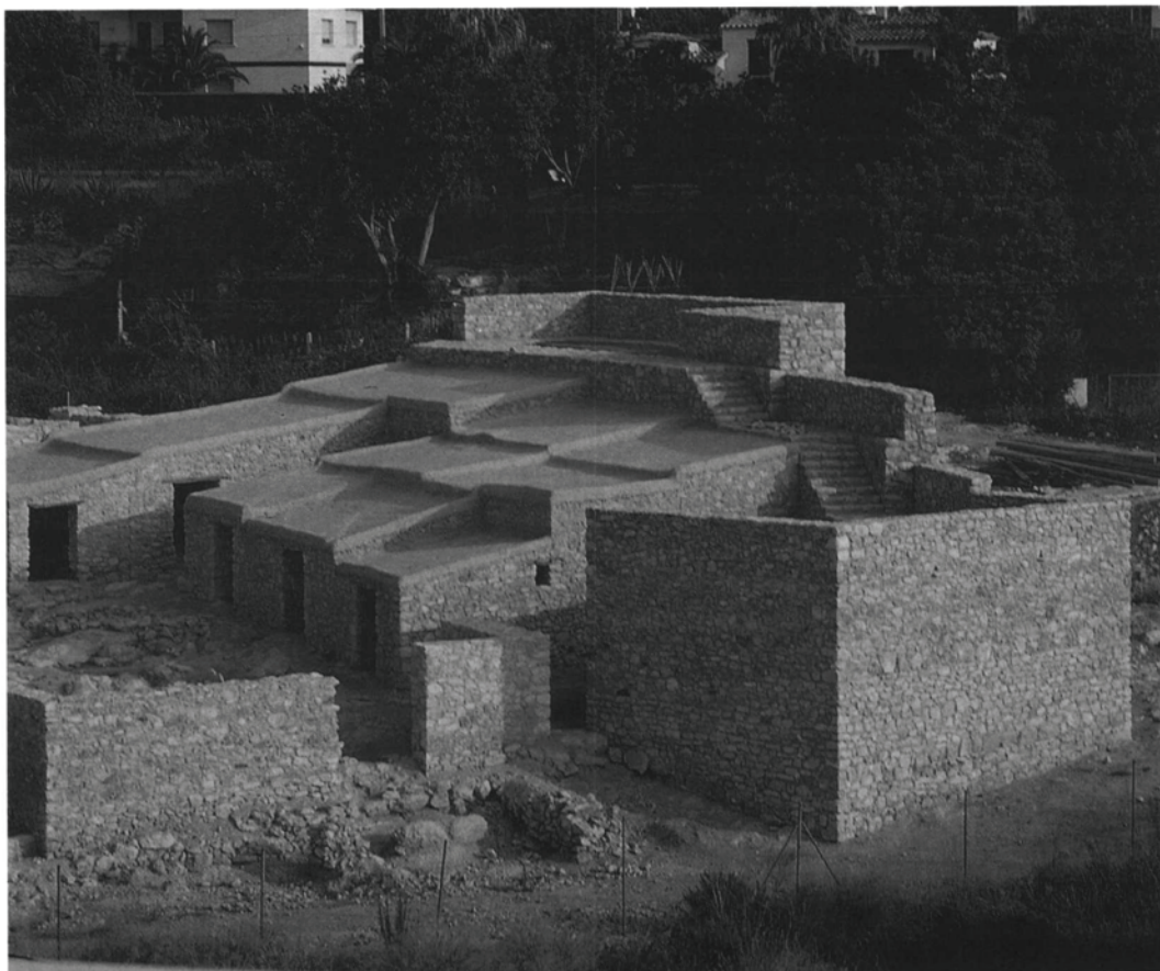
Fig. 2. Aspecte exterior de la reconstrucció.
