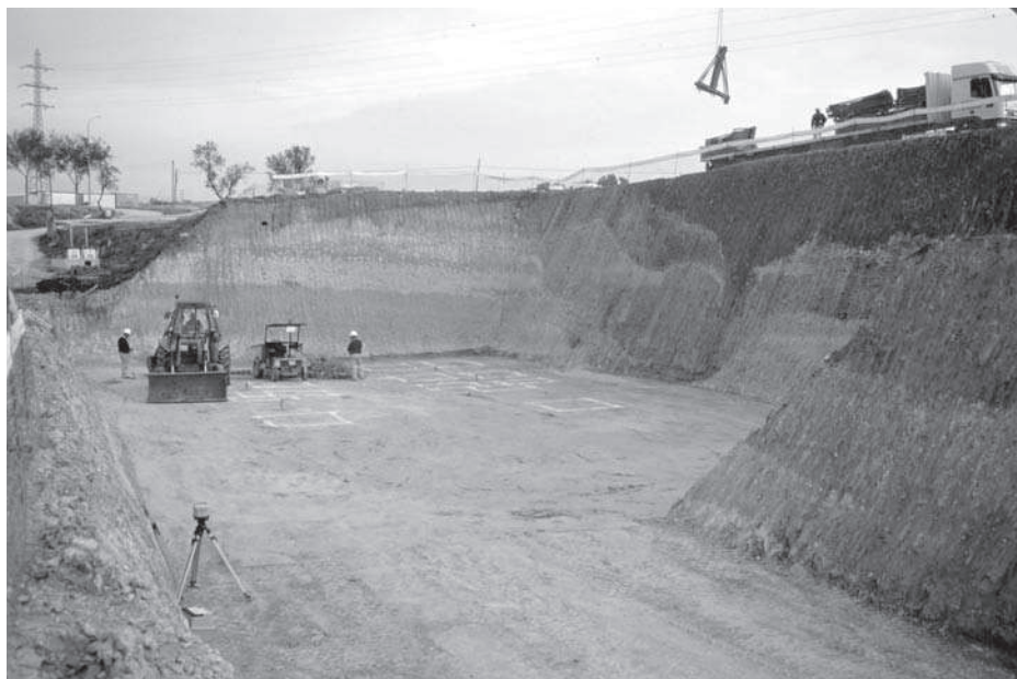
Figura 3. Aspecta dels talussos de l'Edifici de Fangs. Podem observar els forts canvis de coloració dels paquets sedimentaris. La capa superior, de color fortament rogenc, correspon als quaternaris; aquest erosionan els materials vallesians, de coloració verdosa, donant forts paleorrelleus.
