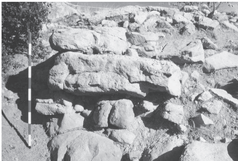
Làmina 1, fig. 2. Mur perimetral, detall d'un dels angles del que devia ser una torre.
