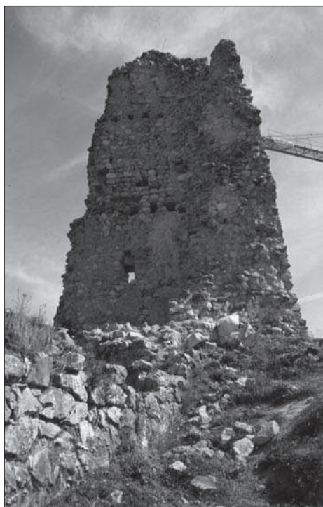
Figura 5. Parament interior de la torre de l'homenatge.
