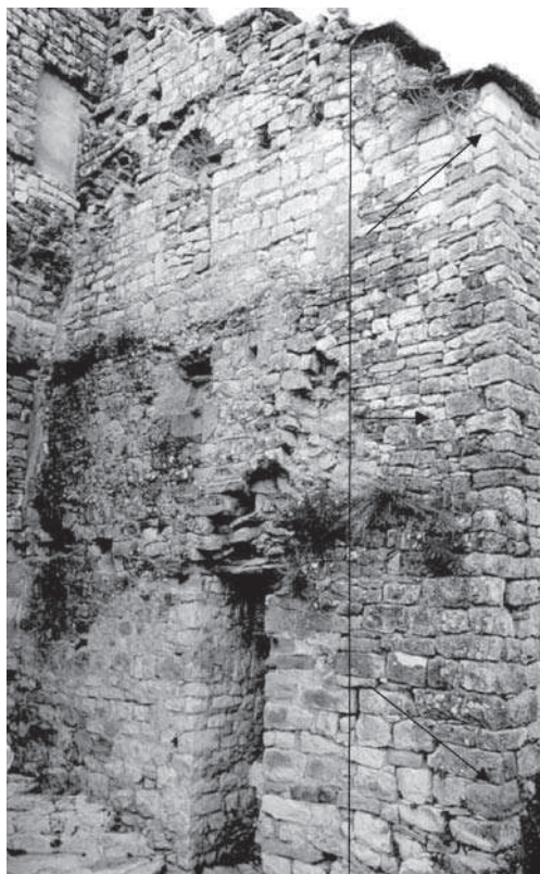
Figura 6. Parament intern de la façana occidental; les línies i fletxes indiquen l'ampliació del mur en direcció nord, realitzada en el moment de construir el claustre romànic.
