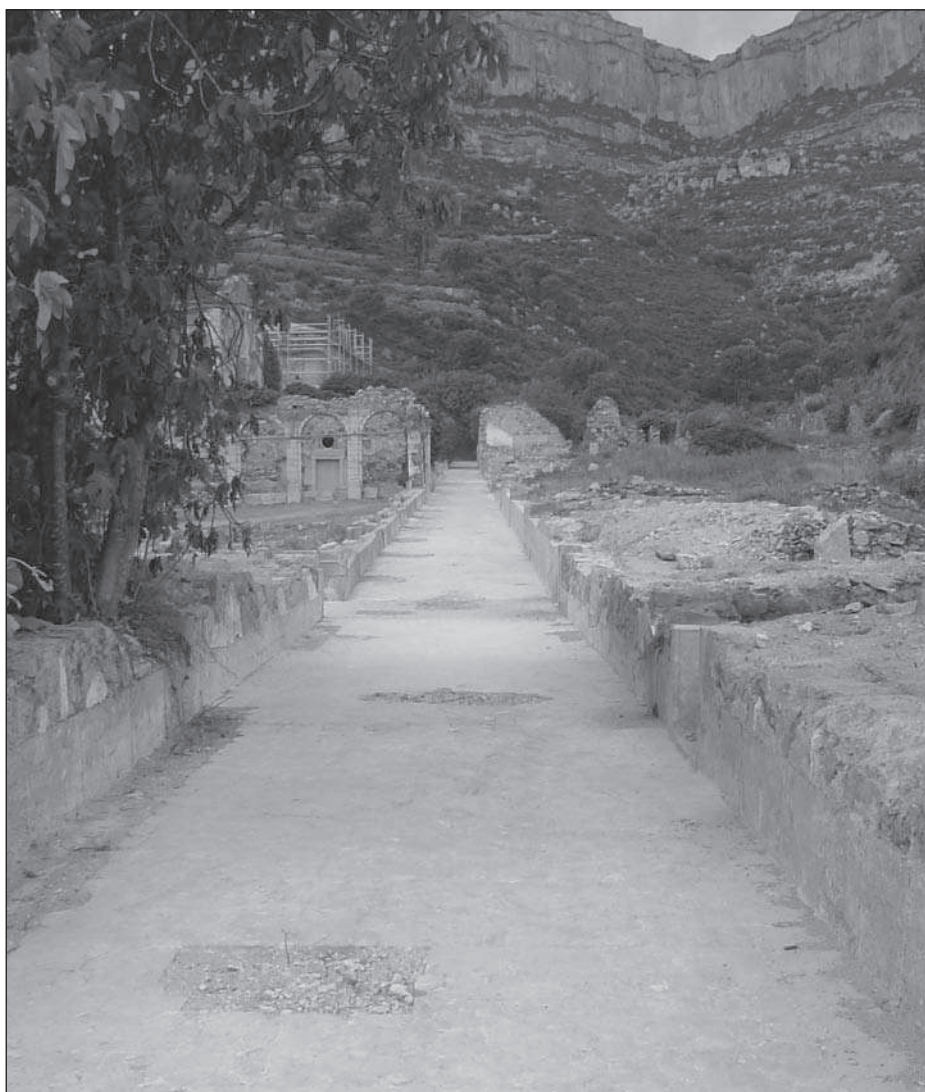
Figura 3. Vista general de la galeria est del claustre un cop finalitzada la intervenció de 2007
