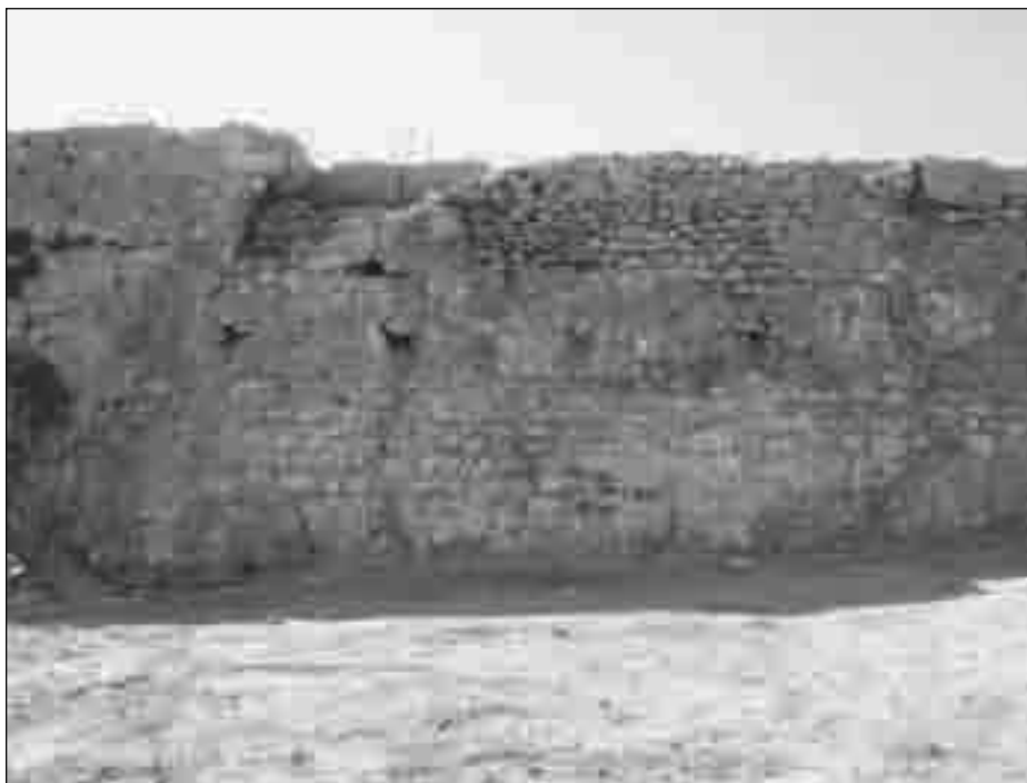
Figura 9. Detall del tram de la façana oriental del pont entre la part esfondrada i l'arc de pas de la riera. S'aprecia la base i el lateral de la caixa romana sota els recreixements i refets medievals i moderns (Codex)
