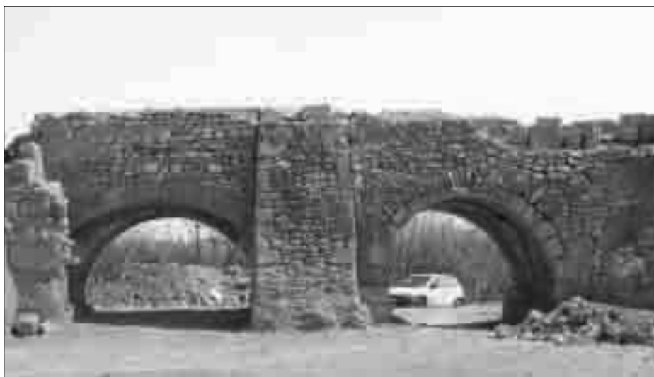
Figura 16. Detall de la façana occidental on s'aprecia l'arc de pas ampliat en època medieval/moderna (Codex)
