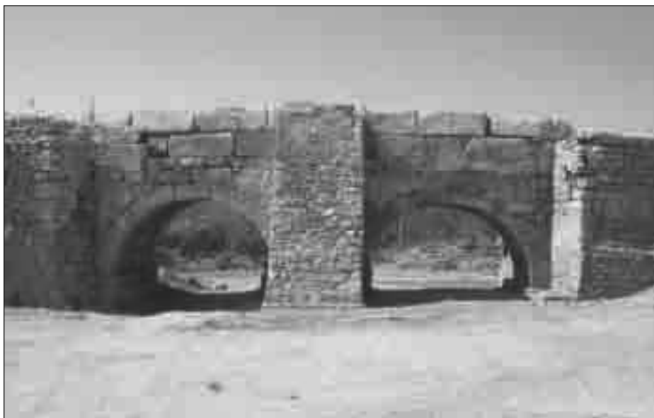
Figura 14. Detall de la façana oriental on s'aprecia el doble arc de pas medieval (Codex)
