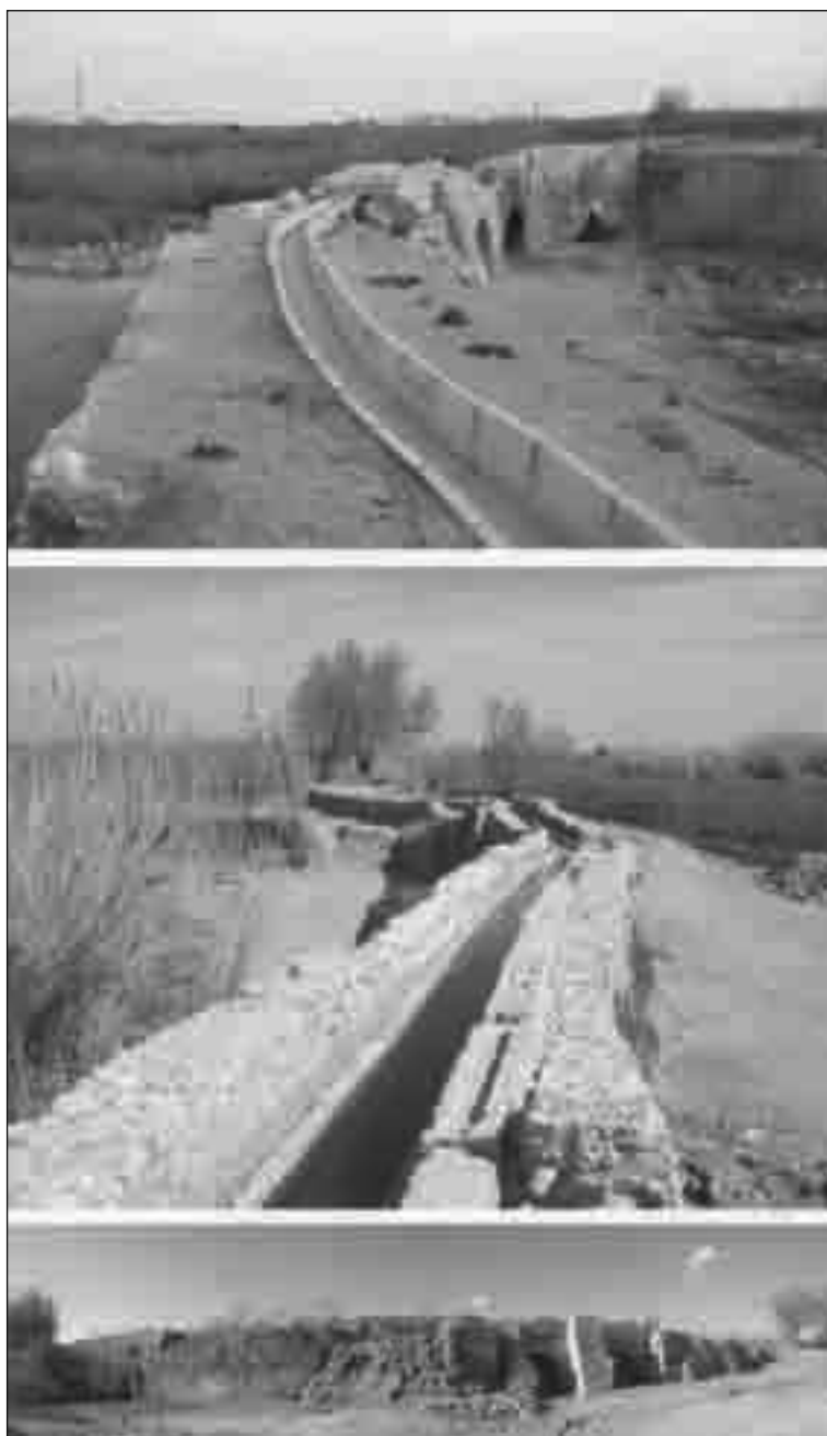
Figura 13. Vista del pont des del nord i des del sud. A sota, façana oriental (J. A. Remolà)
