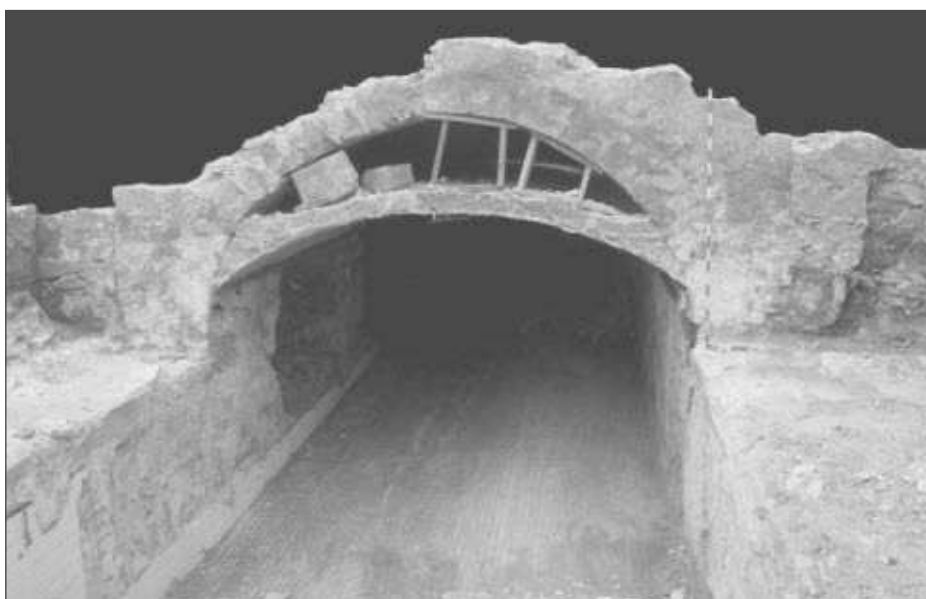
Figura 5. Rec Comtal reaprofitat com a passadís per als vianants que accedien a les vies del tren, a l'estació de l'Arc de Triomf, un cop retirada la volta que a finals del segle XIX cobrí el rec. A la imatge s'observa l'arc nord del pont construït el 1677, i sota aquest, el sostre que es construï quan el rec Comtal s'integrà com a passadís d'accés a les vies. Aquest darrer es comença a documentar a partir d'aquest pont, on l'antiga volta del rec ja ha desaparegut. Fotografia: Jordi Aguelo
