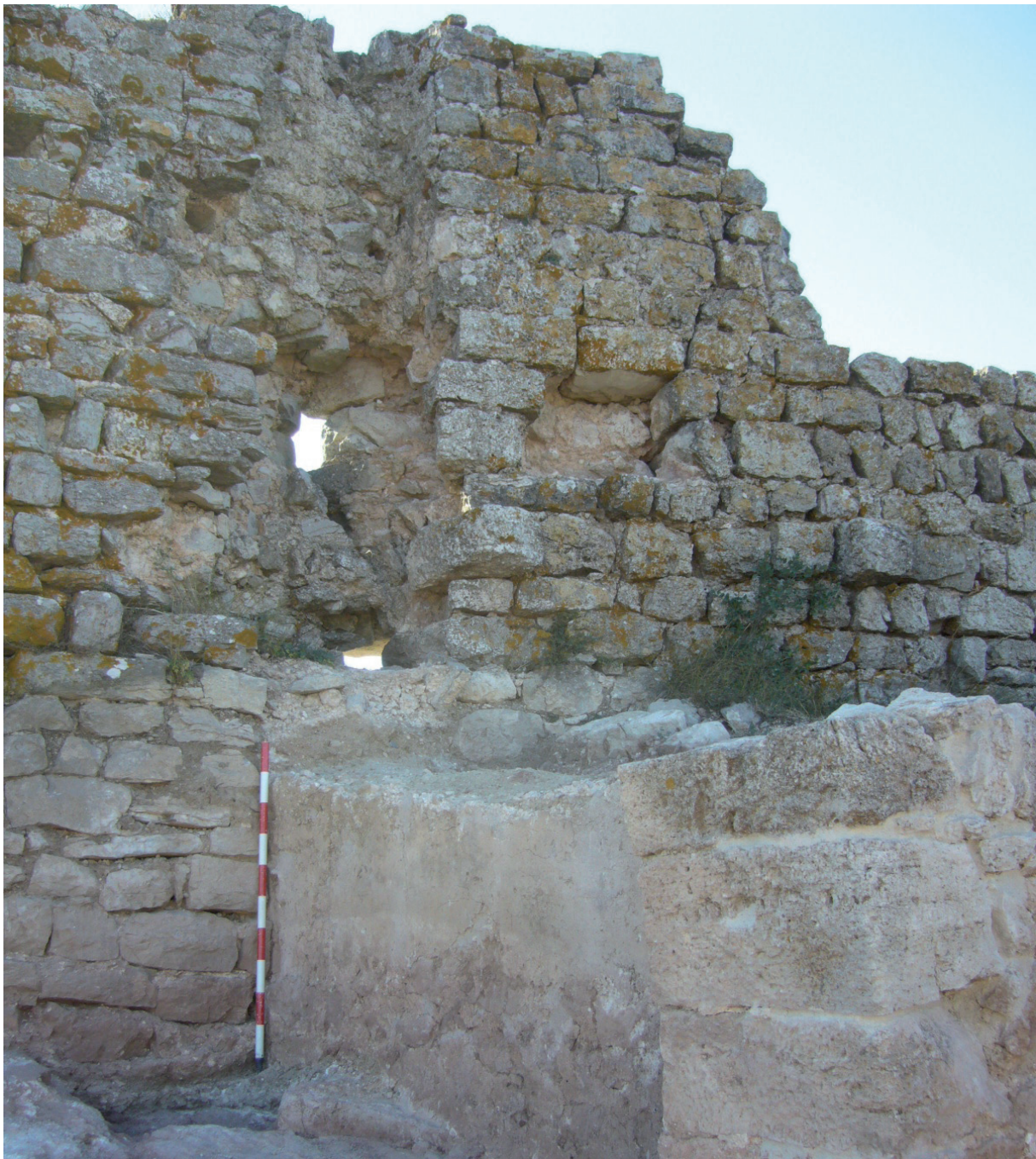
Fig. 5. Mur de tàpia i enlluït de calç que tanca el sector A pel sud-est
