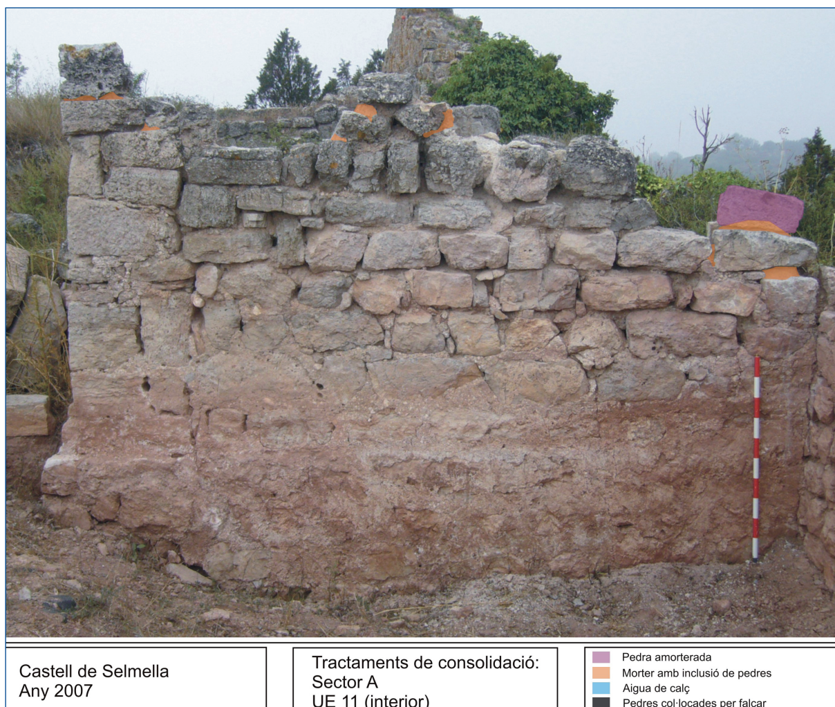
Fig. 8. Exemple de mapatge d'estructura, corresponent als tractaments de consolidació
