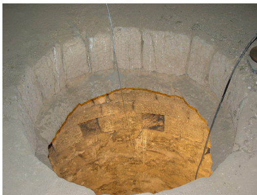
Fig. 13. 1. Vista dels trespols i arcs de l'anella interior; 2. vista de l'arc del tercer nivell amb traspol de fusta conservat; 3. vista del paviment de terra sobre aquest traspol; 4. doble ganxo de l'arc del segon nivell de l'anella interior; 5 i 6. cúpula de la sitja o dipòsit de l'anella interior
