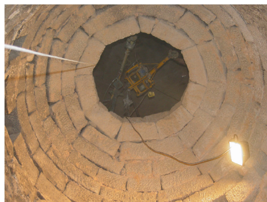
Fig. 13. 1. Vista dels trespols i arcs de l'anella interior; 2. vista de l'arc del tercer nivell amb traspol de fusta conservat; 3. vista del paviment de terra sobre aquest traspol; 4. doble ganxo de l'arc del segon nivell de l'anella interior; 5 i 6. cúpula de la sitja o dipòsit de l'anella interior
