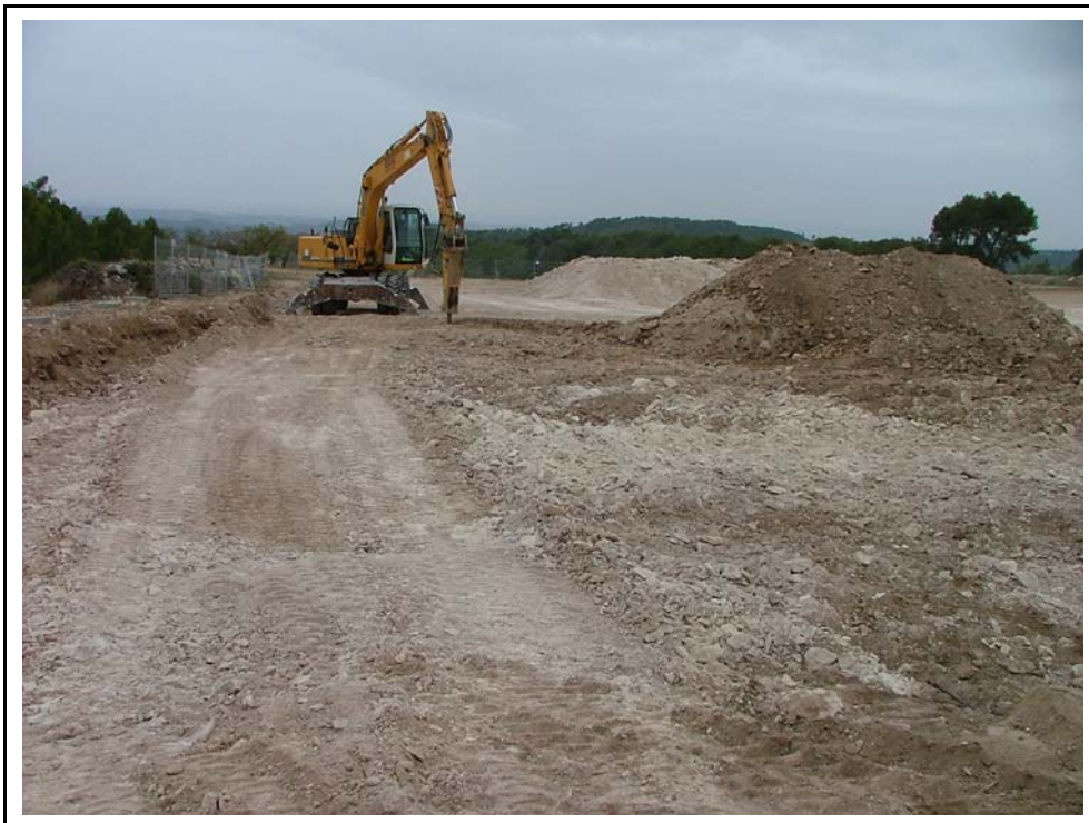
Foto 2. Màquina giratòria amb martell neumàtic realitzant el rebaix del substrat geològic.
