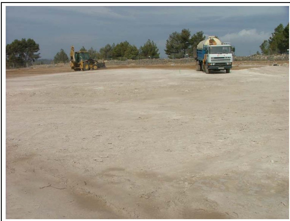
Foto 8. Màquina retirant l'estrat vegetal.
