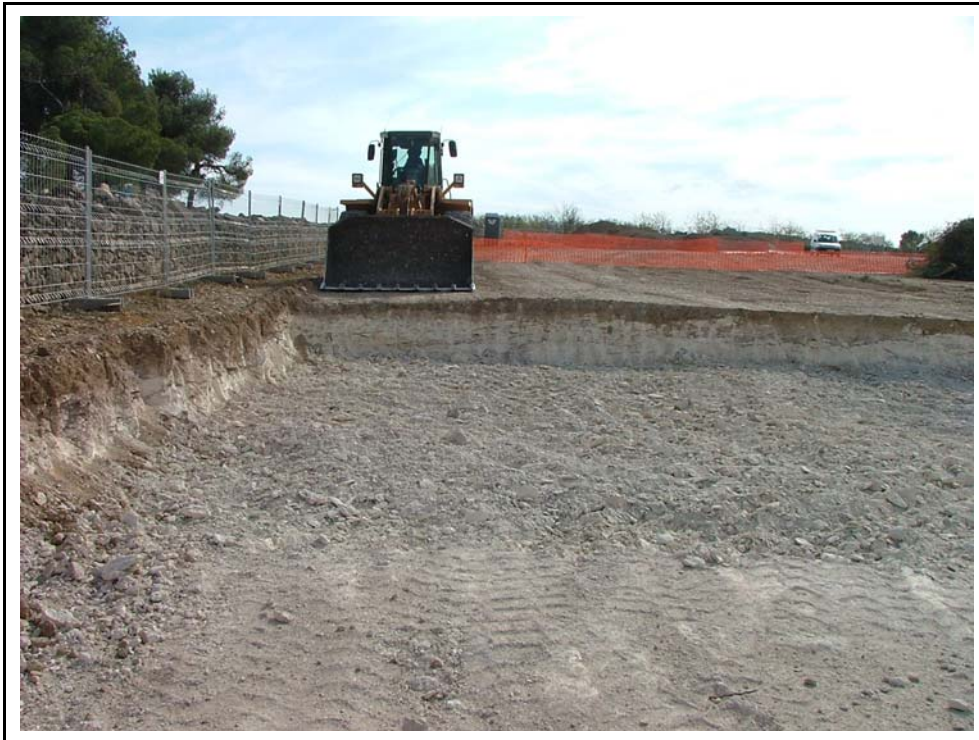
Foto 5. Vista parcial del rebaix de l'obra.
