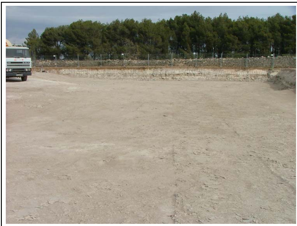
Foto 9. Zona de rebaix.
