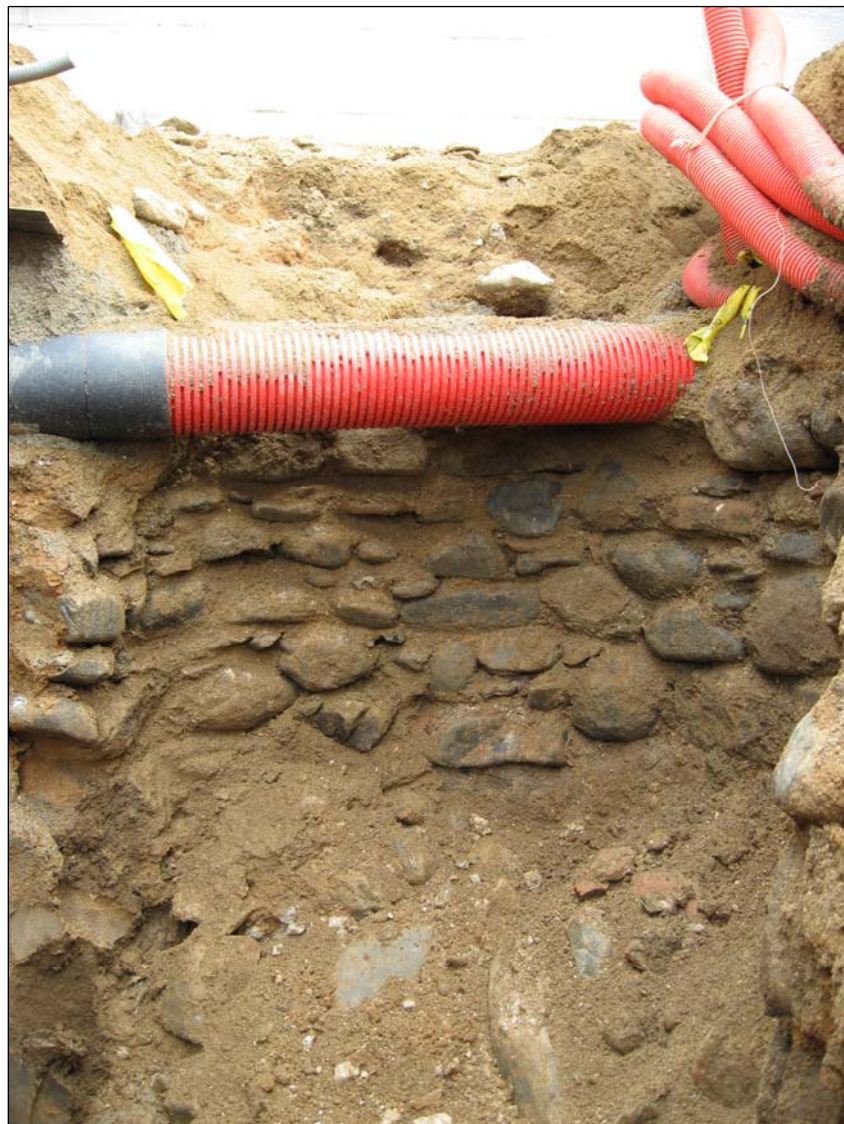
FOTO 5: Detall del pou ( U.E.105 ) vist des d'Oest a Est, el pou construït de pedra seca.
