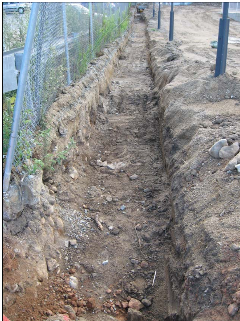
FOTO 14: La rasa 2, tota rebaixada.
