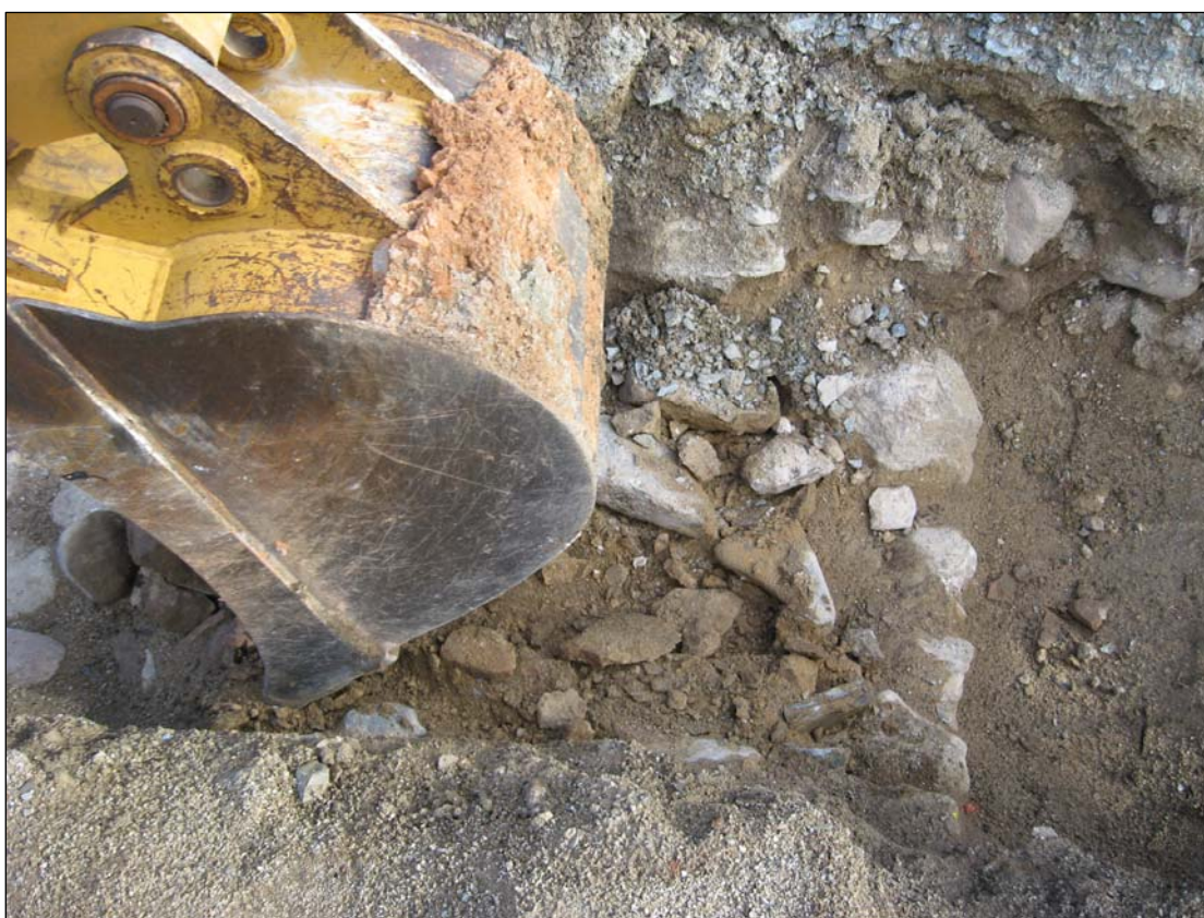
FOTO 15: Desmuntatge de les primeres dues filades del mur ( U.E. 204)
