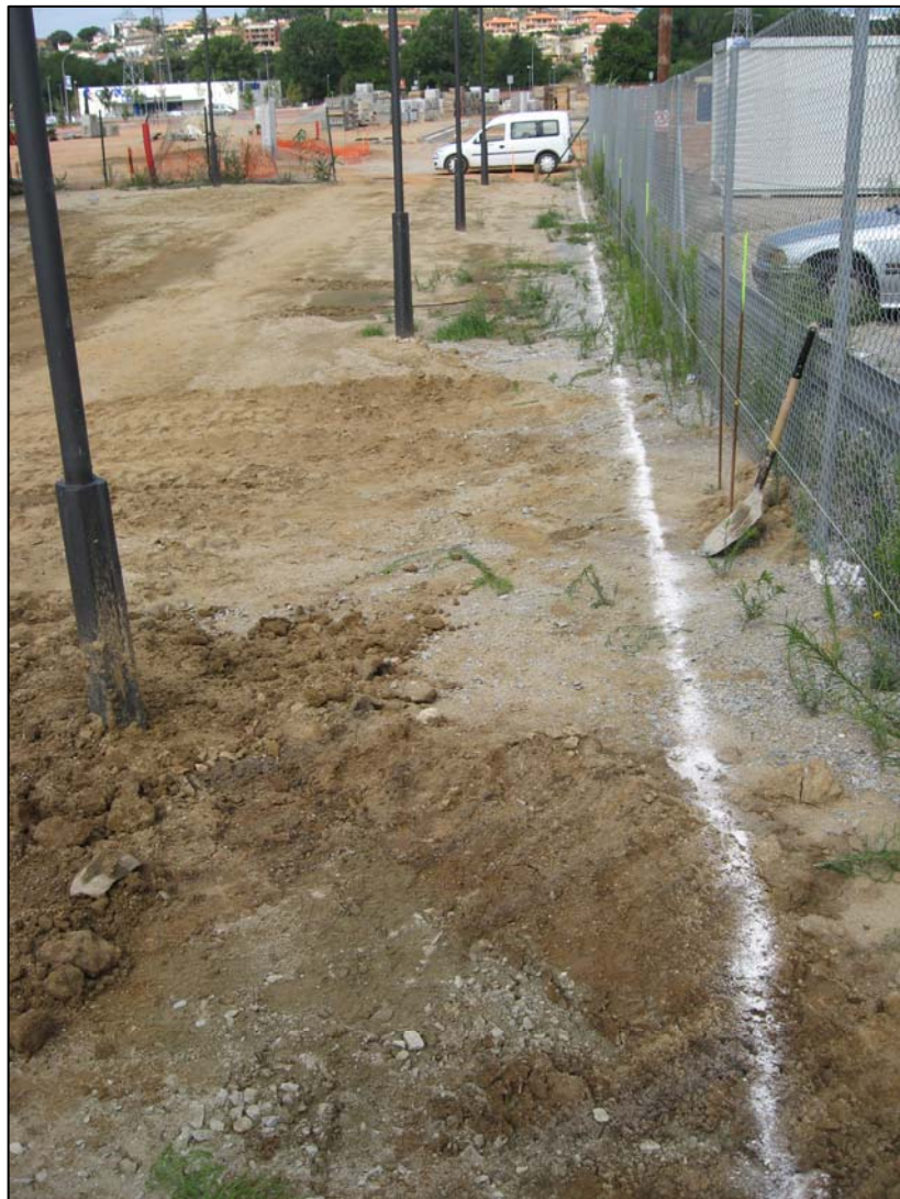
FOTO 7: La Rasa 2, marcada al terra, abans de rebaixar-la.
