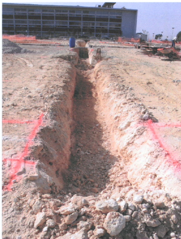
FOTO 6. Vista d'una de les rases de fonamentació
