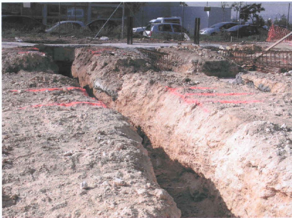
FOTO 8. Una altra vista d'una de les rases de fonamentació
