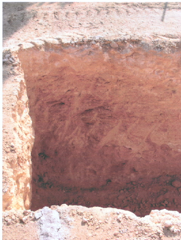
FOTO 10. Vista del tall d'una de les rases de fonamentació
