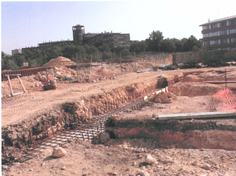
FOTO 4. Una altra vista general dels rebaixos de les fonamentacions
