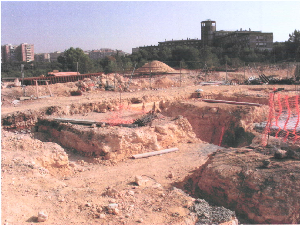
FOTO 3. Vista general dels rebaixos de les fonamentacions
