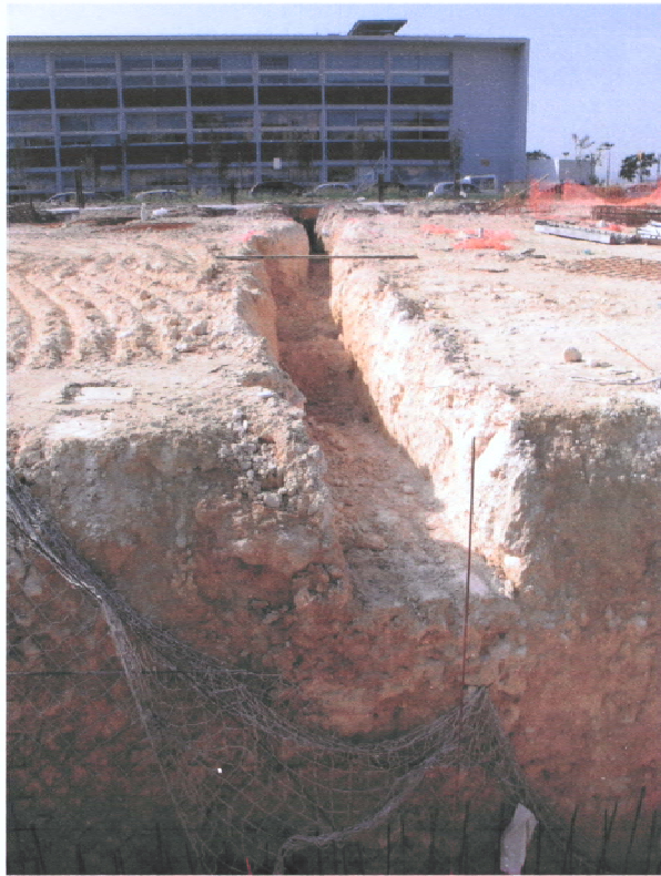
FOTO 9. Una altra vista d'una de les rases de fonamentació
