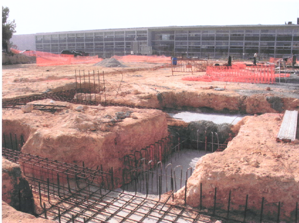
FOTO 5. Una altra vista general dels rebaixos de les fonamentacions
