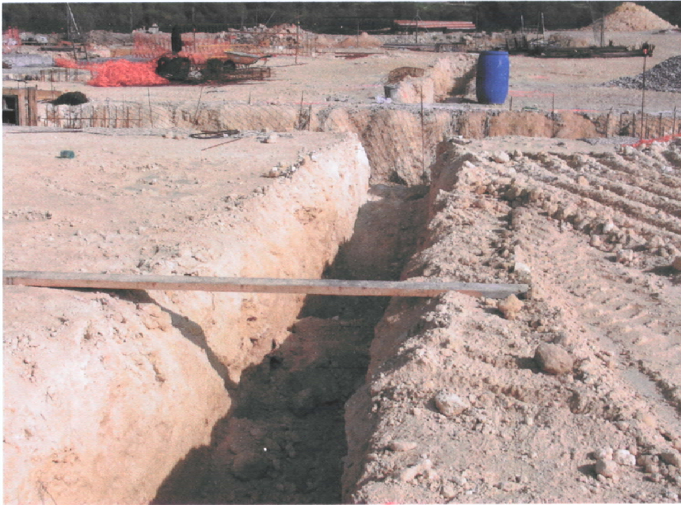
FOTO 7. Una altra vista d'una de les rases de fonamentació
