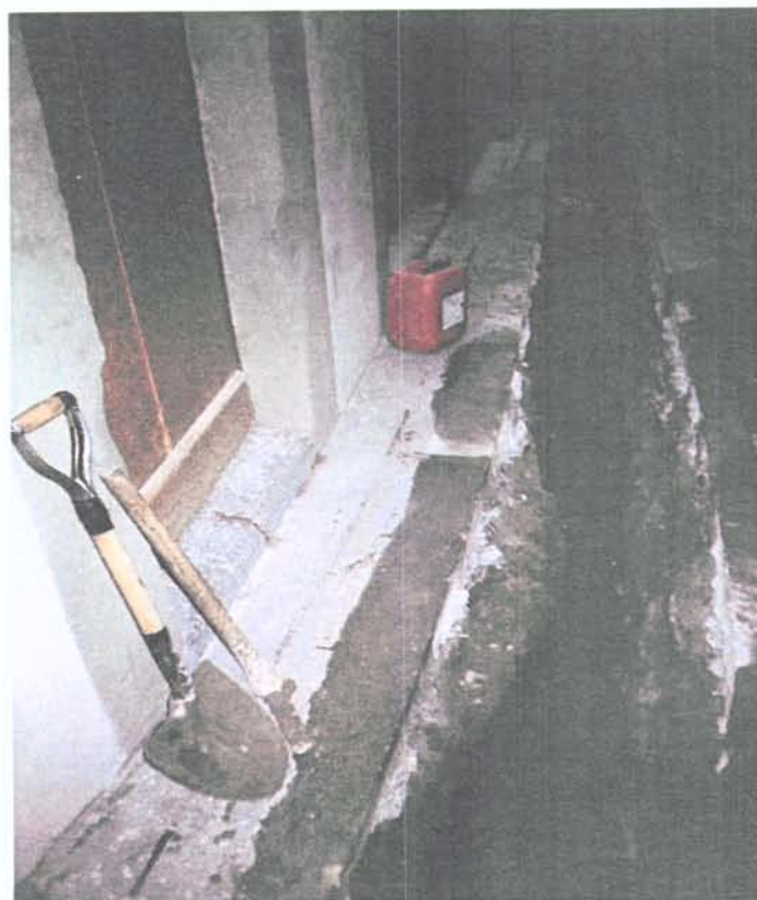
F2.Rasa 1000. C/ dels Assaonadors. Tram de rasa finalitzada.
