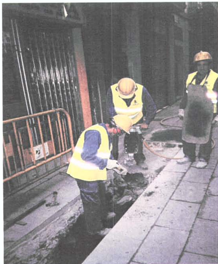
F1.Rasa 1000. C/ dels Assaonadors. Aixecant paviment amb martell pneumàtic.
