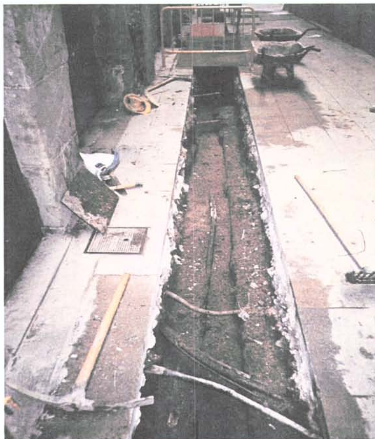
F7.Rasa 5000. C/ d'en Boquer. Rasa finalitzada.
