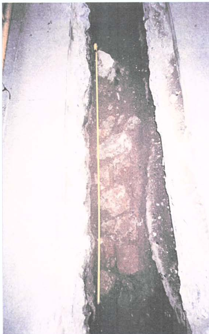
F.13. Rasa 1000. Carrer del Assaonadors. Estructura 1003.
