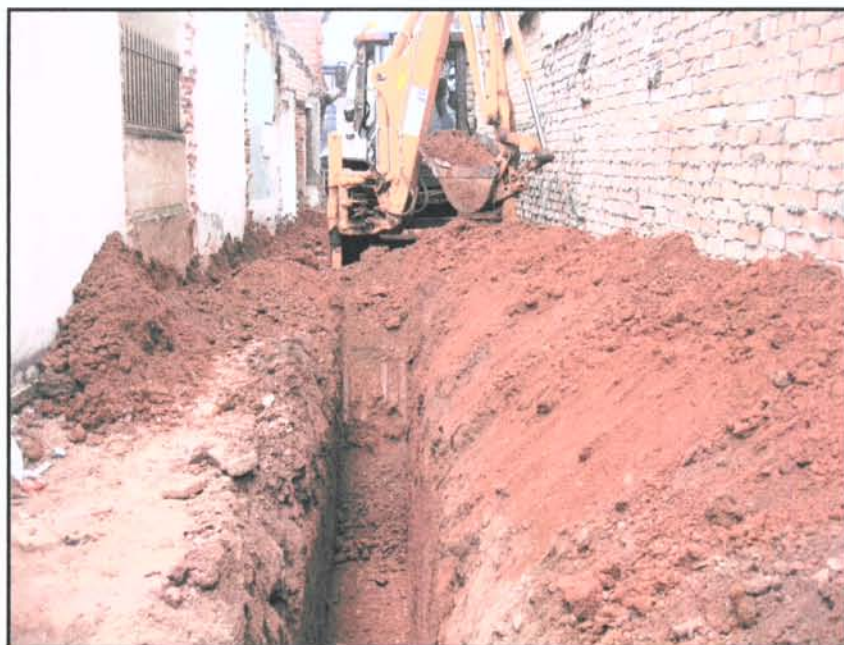
Excavació del tram 2 de la rasa.
