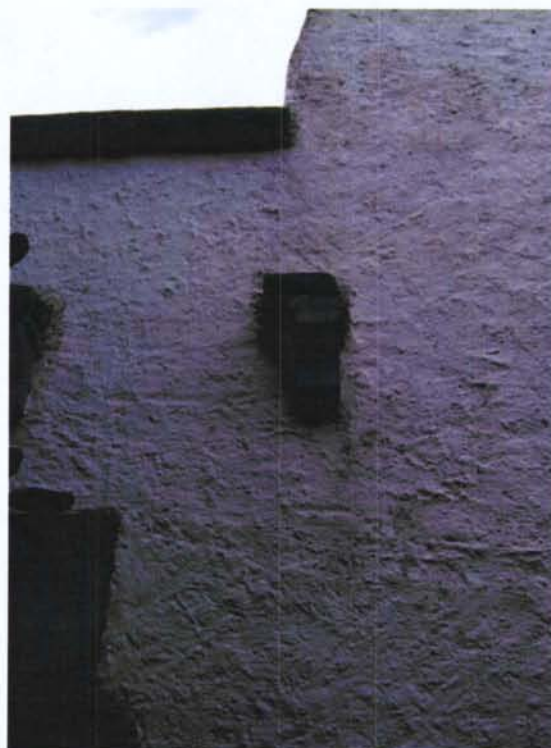
135. Detall façana lateral
