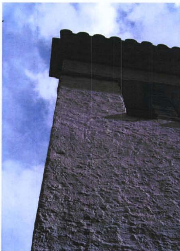
125.Obrador.Detall Cornisa i finestres
