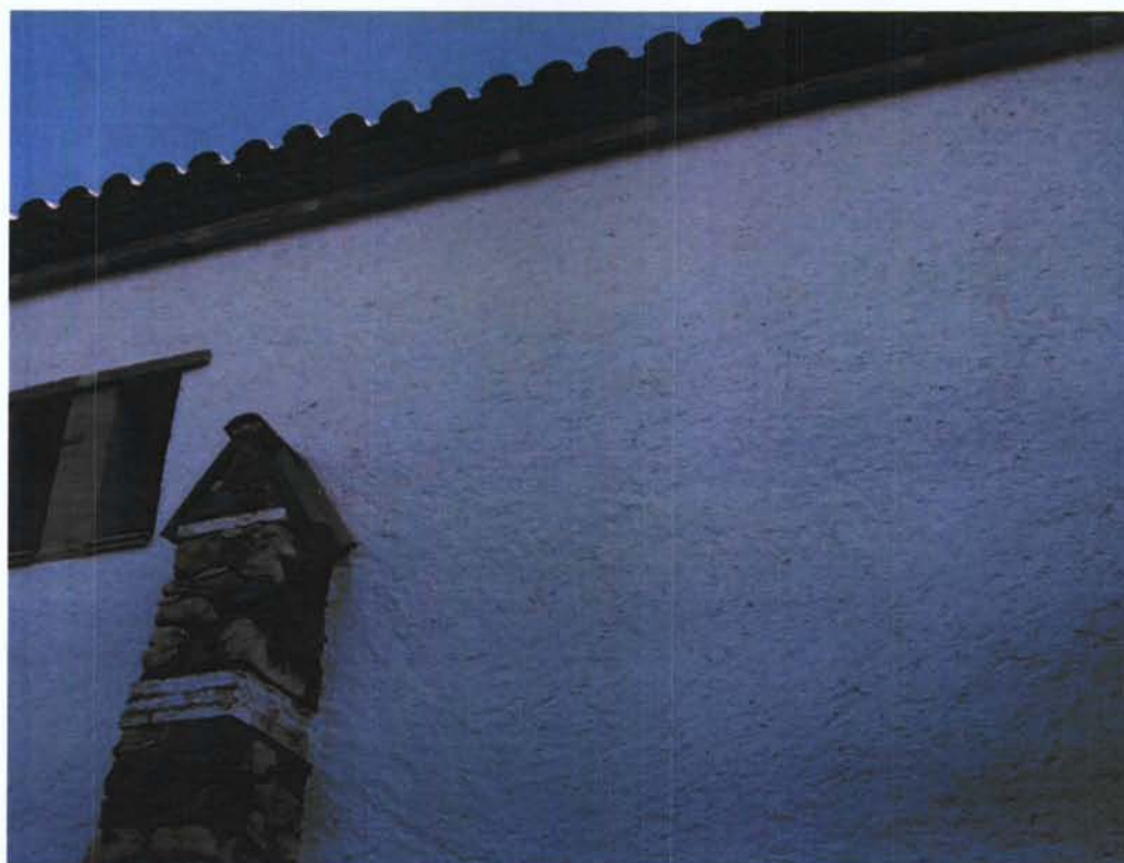
116.Obrador. Detalls façana
