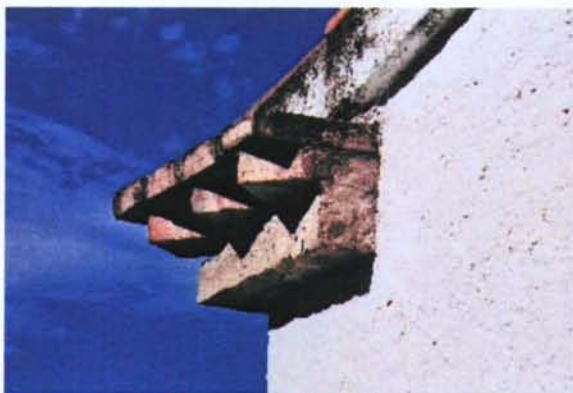
97. Obrador. Detalls de la façana
