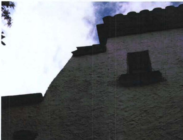
132. Obrador. façana lateral
