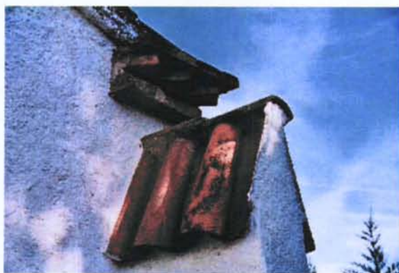
98. Obrador. Detalls de la façana
