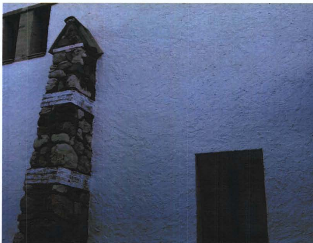
115.Obrador. Detalls façana
