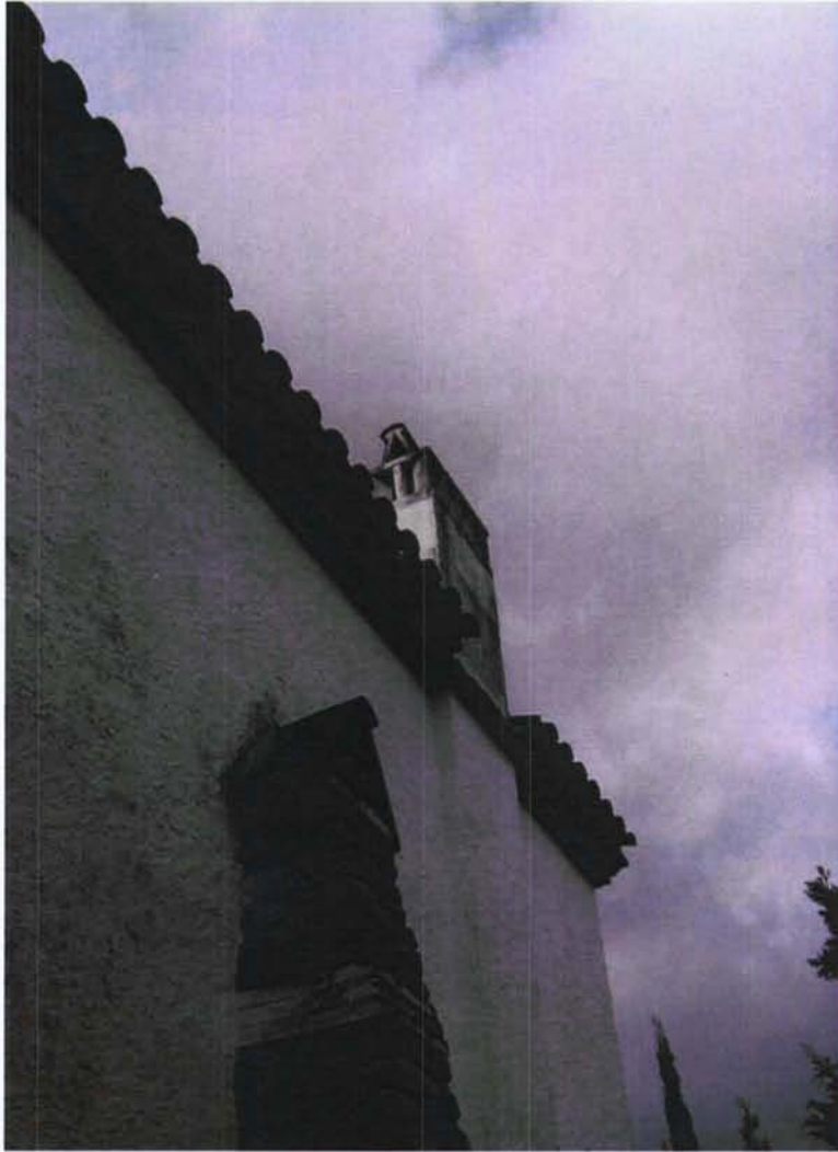
131. Obrador. Xemeneia i zona superior del contrafort
