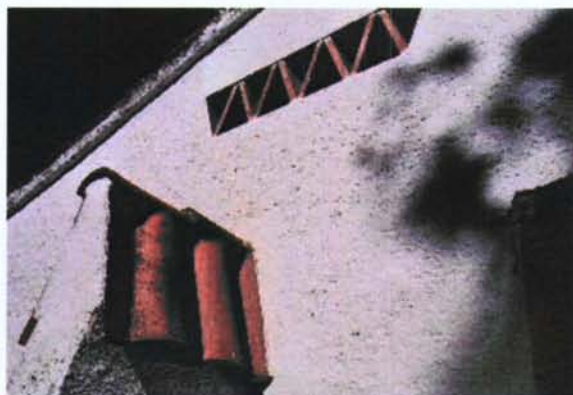
96. Obrador. Detalls de la façana
