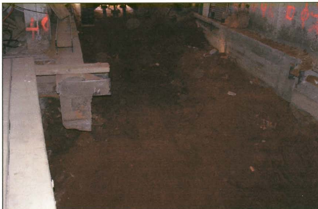
7. Tasques d'extracció de terres a l'àmbit del soterrani
