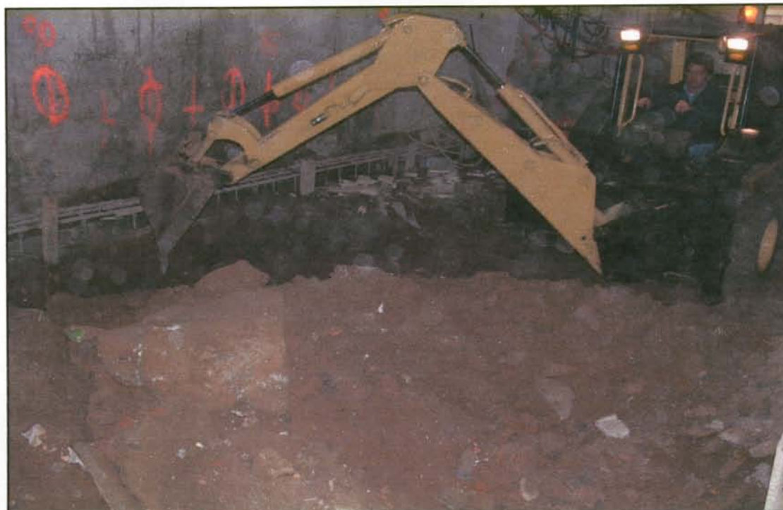
6. Tasques d'extracció de terres a l'àmbit del soterrani
