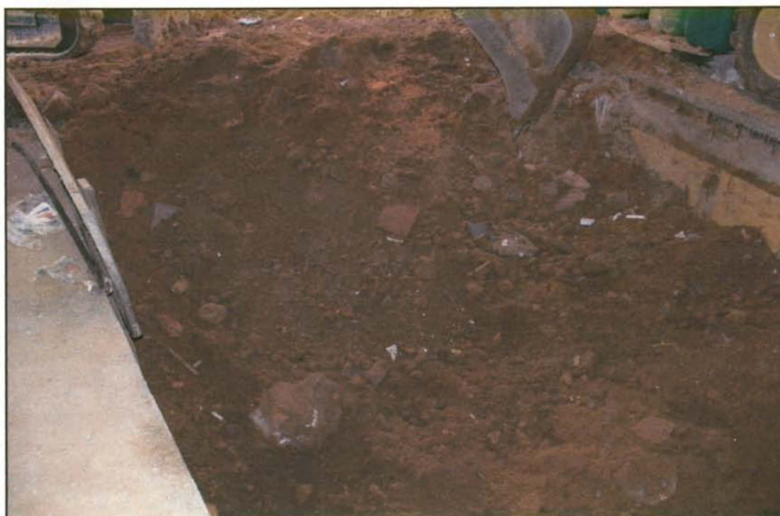
5. Inici dels rebaixos del soterrani.
