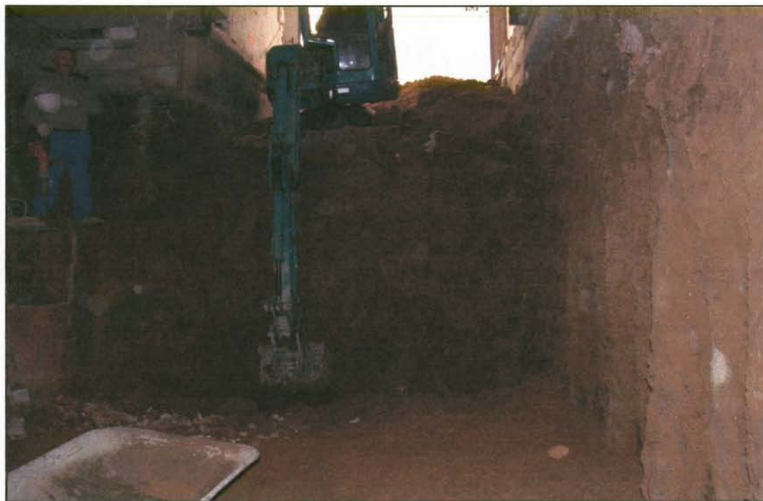
8. Final de l'extracció de terres del solar.
