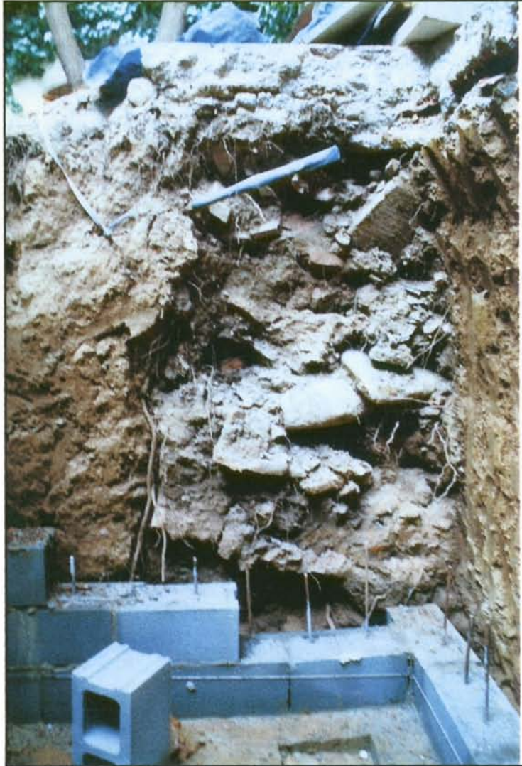
3. Pou de runa documentat a la paret oest del dipòsit.
