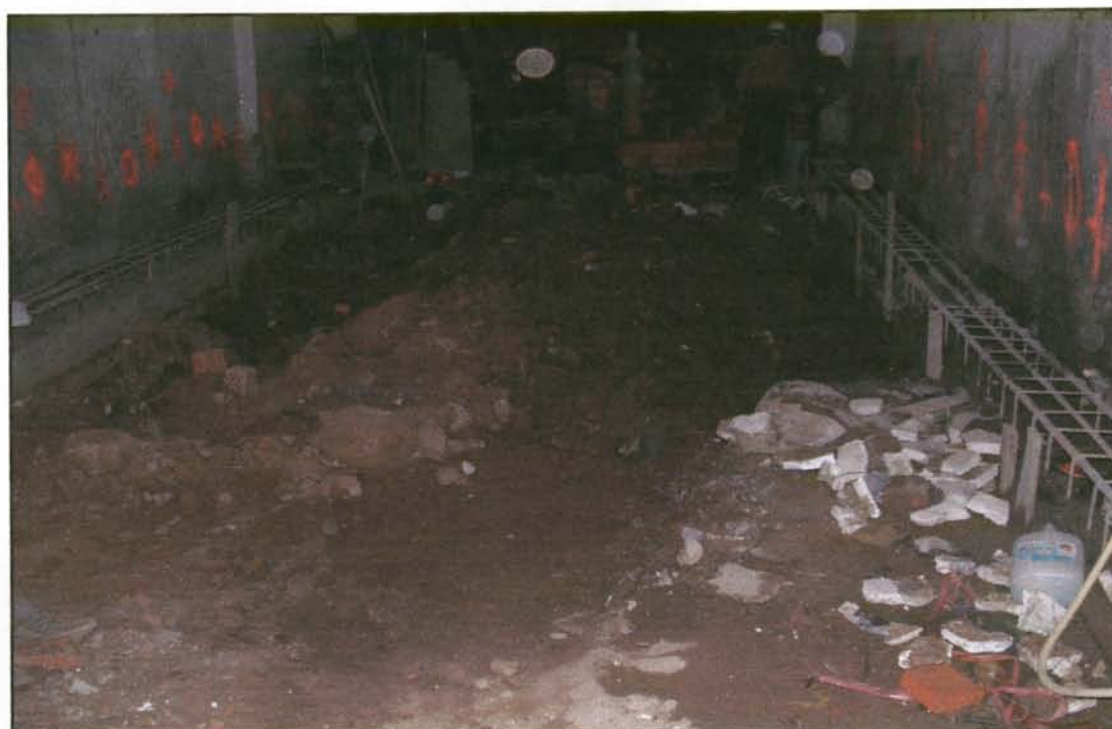
4. Vista general del soterrani a rebaixar
