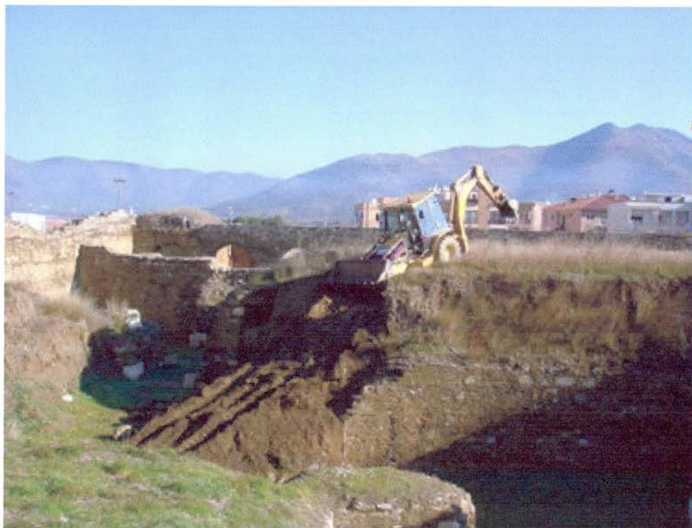
Fig. 2: Rampa d'accés per al rebaix de terres de la part superior del baluard
