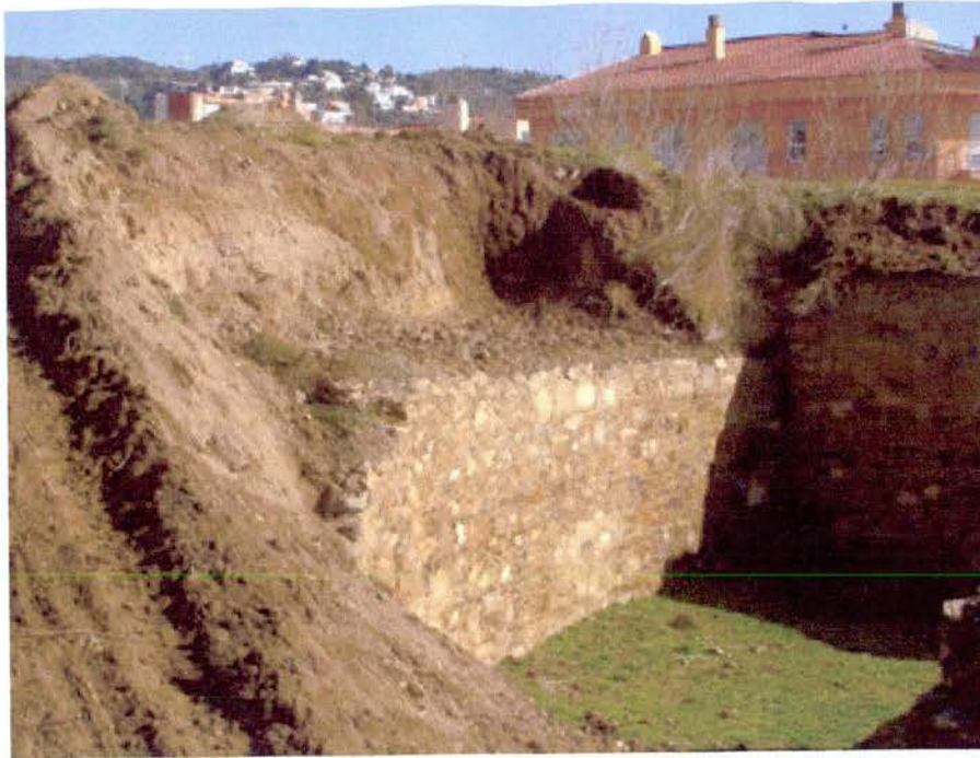
Fig. 3: Rebaix de terres per damunt del coronament de les casamates
