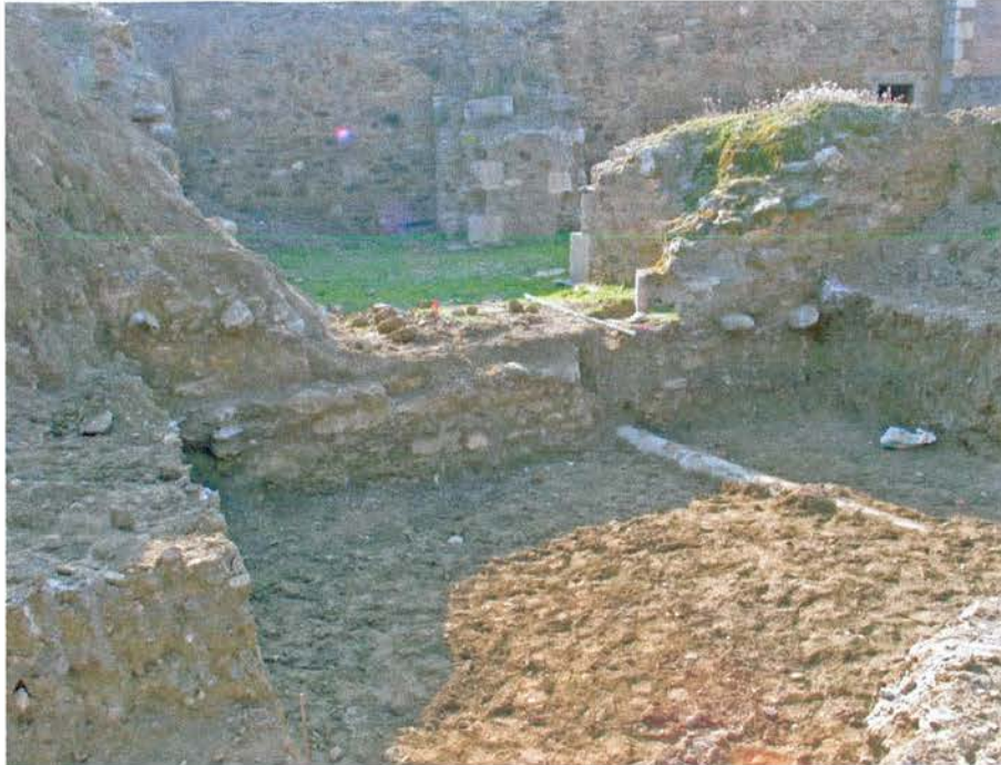
Fig. 7: Rebaix de la part frontal de la casamata del flanc sud, en el qual es fa evident la manca de cap estructura corresponent al túnel d'accés projectat per Calvi
