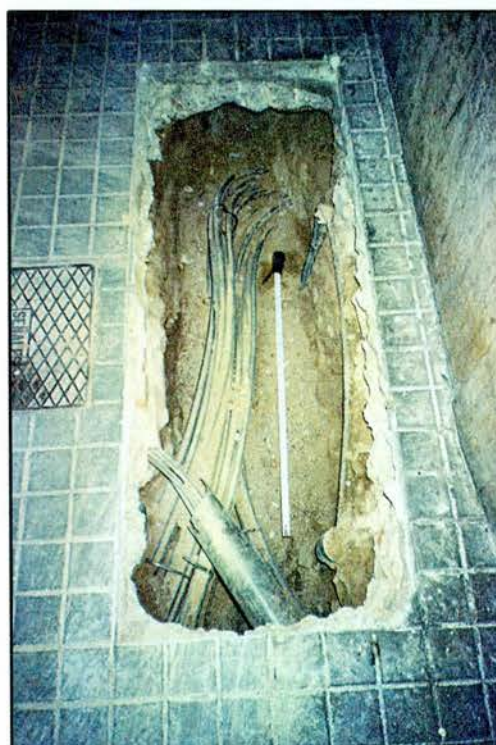
Foto 2: Detall del tram 300 de la rasa.
