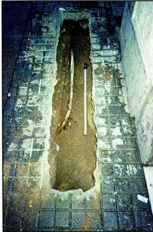
Foto 3: Detall del tram 200 de la rasa.
