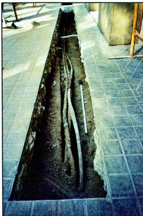
Foto 1: Detall del tram 100 de la rasa
