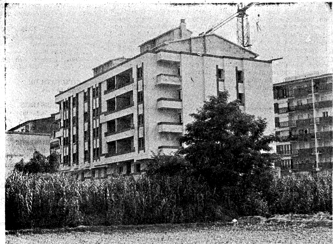
EDIFICIO EN TRAVESIA SANTA EUGENIA, N.º 2 Y 4 (antes General Mola)
