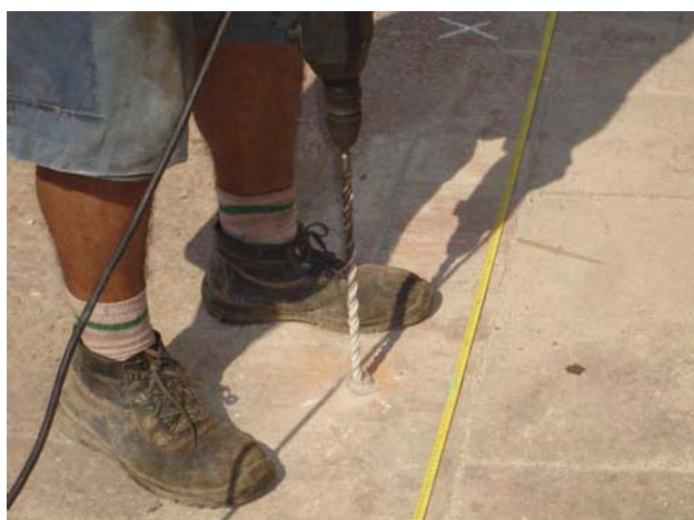
Fotografias 11 y 12. Fotografias del perfil 6 donde se muestra como se perforó el terreno y la perforación posterior donde se ubican los diferentes electrodos.
