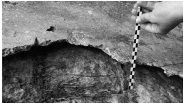
Figura 3. Detall de la separació del revestiment, de les arrels que surten de dins i de la presència de microorganismes.
