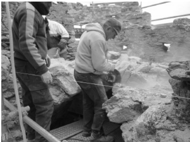
Figura 3. Moment en què es retalla la volta que aguanta la coberta de la torre. Aquesta modificació va ser feta per facilitar l'accés al públic.
