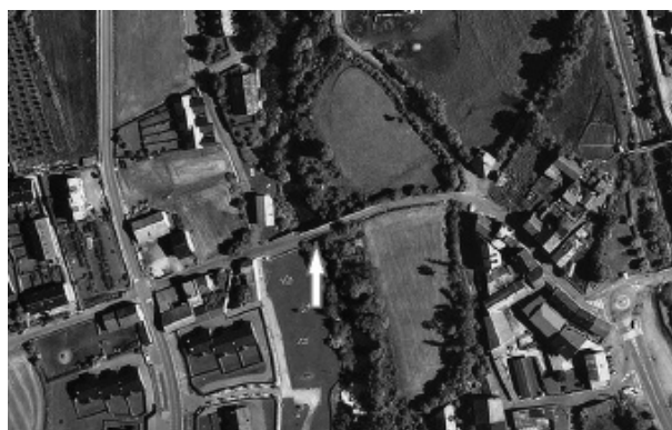
Figura 2. Situació del pont de Sant Martí. Ortofoto 1:5.000 Institut Cartogràfic i Geològic de Catalunya.
