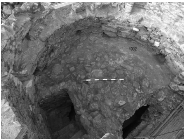
Figura 4. Vista de la part superior de la coberta un cop excavada, des del nord-est, on es visualitza la volta feta d'obra i les restes del nivell de calç UE 1002.
