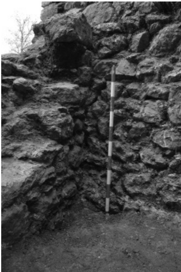
Figura 4. Bestorre quadrangular. Vista del mur del parament intern al sud construït sobre mur perimetral antic.
