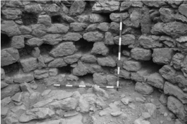
Figura 2. Imatge del parament interior de la torre circular de migdia amb restes de lloses de paviment i els nínxols del colomar.
