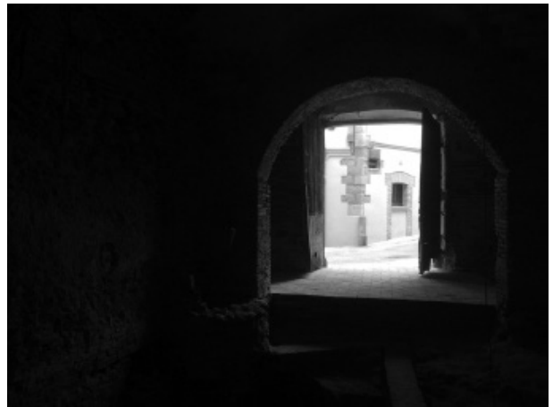
Figura 6. Vista general de l'espai interior de l'edifici, després de la intervenció.
