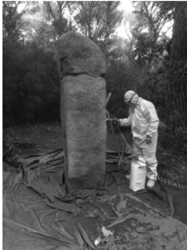
Figura 4. Procés de neteja amb projecció controlada d'abrasius.
