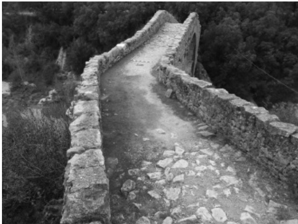
Figura 3. El nivell de circulació UE 1001 es va aportar per suavitzar el pendent existent a la meitat oriental del pont i facilitar el pas dels carruatges. Tant en primer terme com al fons de la imatge es pot apreciar l'empedrat original UE 1003.
