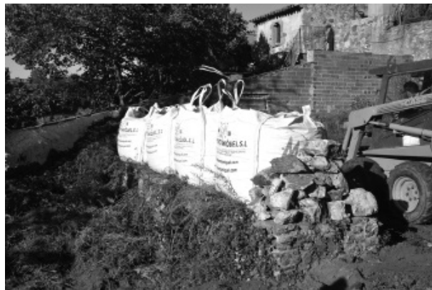
Figura 5. Mur construït en el segle XX, seguint la traça de l'antiga muralla.
