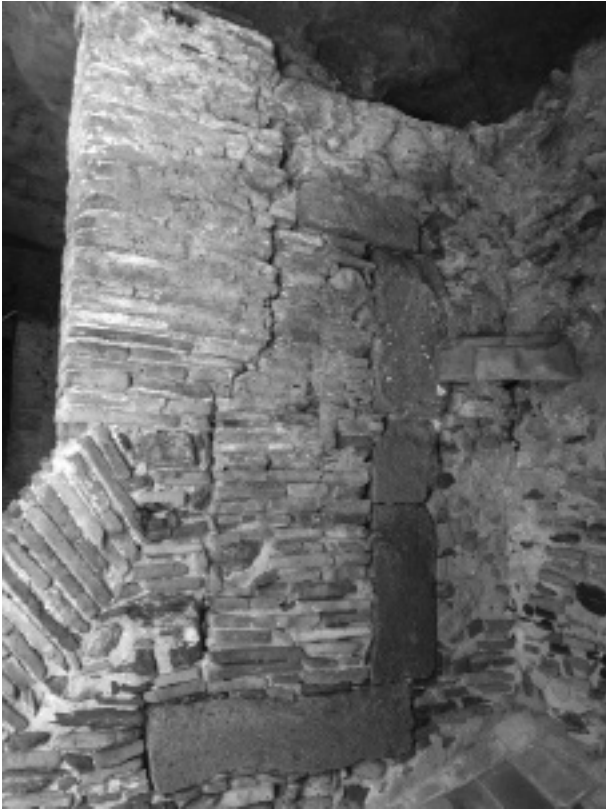
Figura 3. Detall dels paraments interiors, després de la intervenció.
