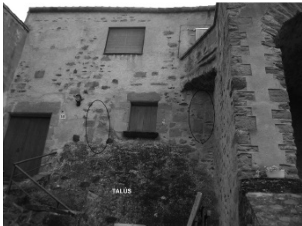
Figura 4. Vista del costat nord de la façana oest. Els cercles indiquen dues espitlleres.
