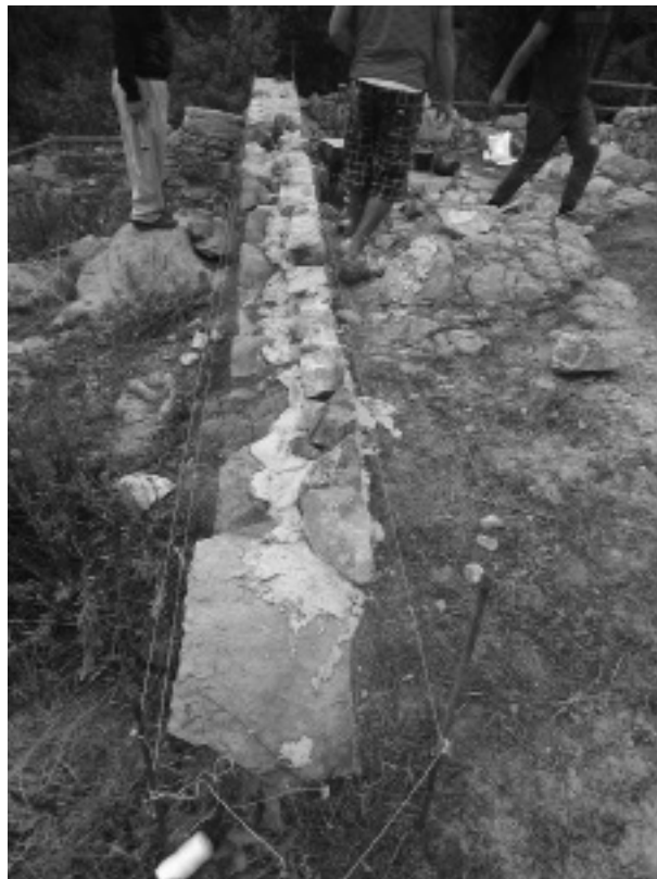
Figura 2. Col·locació de la malla i col·locació de les pedres del sòcol.
