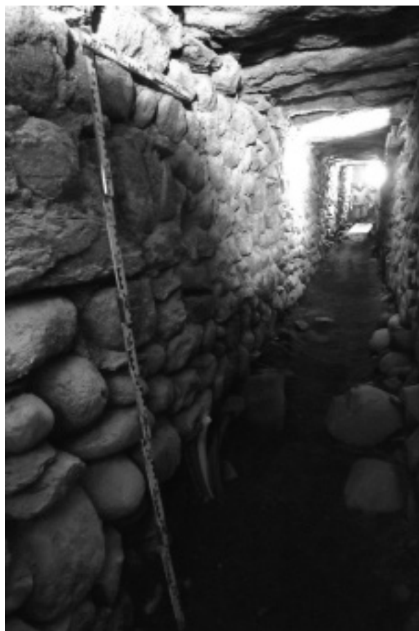
Figura 1. Vista del segon tram del túnel (Júlia Miquel).
