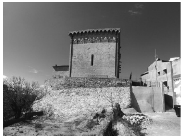
Figura 3. Tram est de la muralla després de la intervenció.
