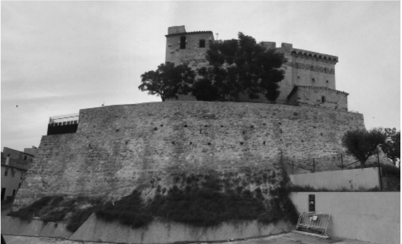
Figura 2. Tram sud de la muralla després de la intervenció.
