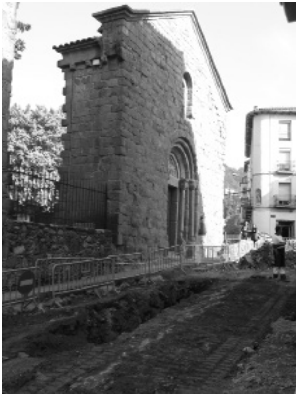
Figura 6 a-b. Segona fase. Carrer de Sant Pol. Obertura de la rasa 300 amb el col·lector central (UE 106) i la façana de l'església de Sant Pol.
