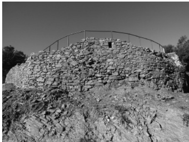
Figura 5. Detall del mur M-27 un cop consolidat.
