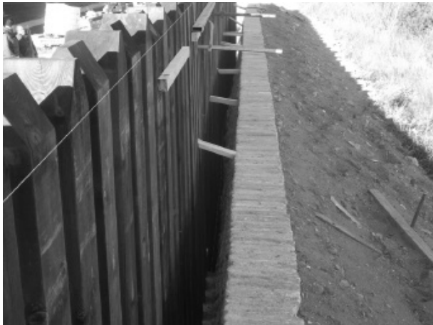
Figura 6. Parapet amb el sardinell restituït i part de l'estacada darrere del mateix sardinell.
