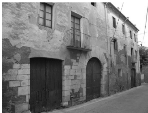
Figura 1. Façana exterior de l'edifici.
