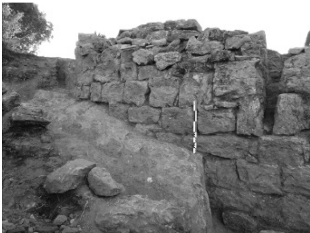
Figura 2. Extrem est del mur 4001 en punt rodó, vist des del nord. Al costat dret s'observa una espitllera.
