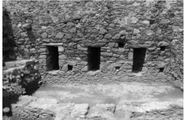
Figura 3. Vista des de l'est de les espitlleres de la muralla.
