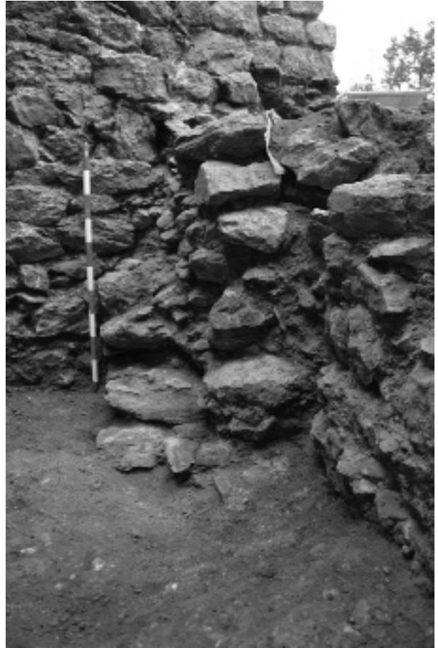
Figura 3. Bestorre quadrangular. Vista del mur del parament intern al nord construït sobre mur perimetral antic.
