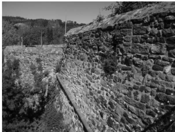
Figura 5. Tram de muralla al sud-est de la casa. S'hi aprecien clarament una espitllera i el talús.
