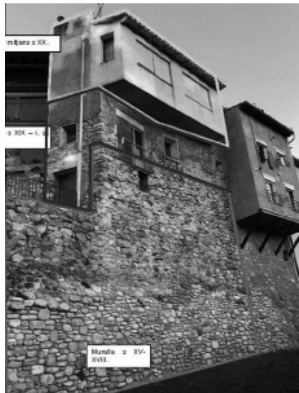
Figura 3. Vista general del parament posterior de la casa, amb la delimitació de les diverses fases constructives.
