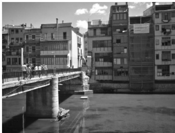
Figura 1. Vista, des de la riba oest de l'Onyar, de l'edificació en obres.
