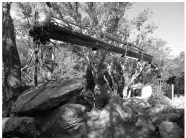
Figura 7. Extracció de la coberta.
