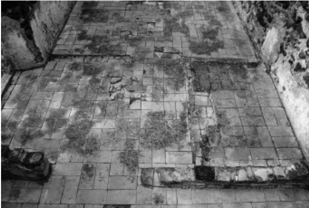
Figura 4. Tram del paviment intern de l'edifici Nord.
