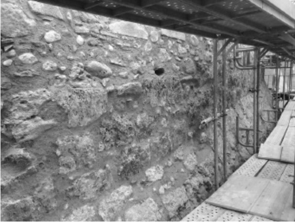
Figura 5. Detall del parament del tram est després de la intervenció.
