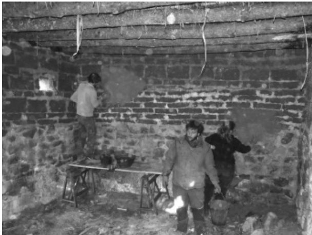
Figura 9. Aplicació de l'arrebossat.
