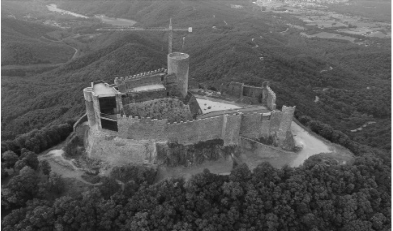
Figura 17. Façana oest del castell de Montsoriu restaurada.
