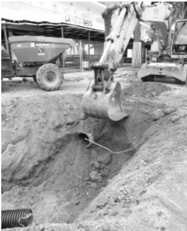
Figura 3. Fotografia de la realització d'una rasa on s'observa el sòl de tipus sorrenc de textura i color molt similar a la sorra de la platja.
