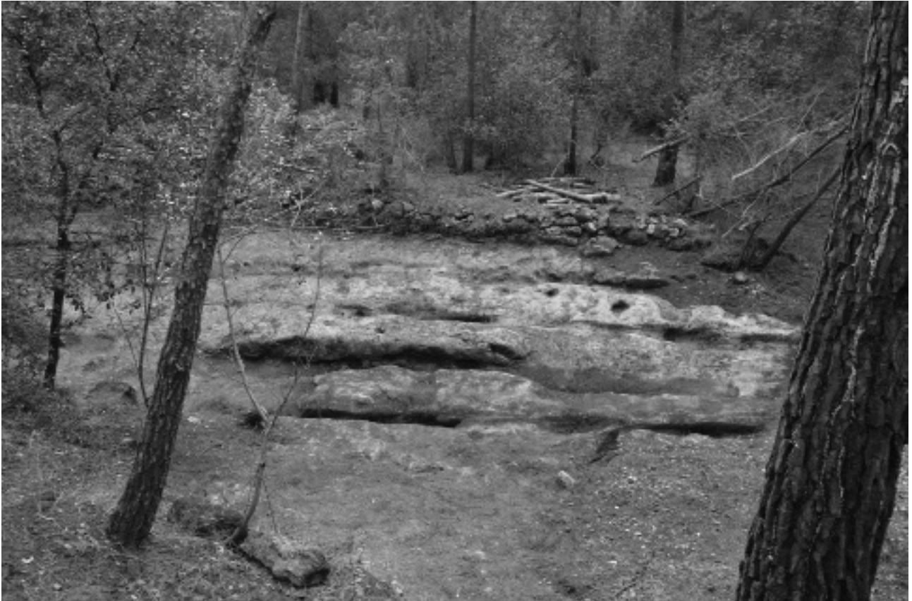
Figura 3. Vista general del camí, presa des de l'oest, en la que s'aprecien les dues filades de roderes, així com la diferència de cota entre els dos marges del camí, més alt a l'oest.
