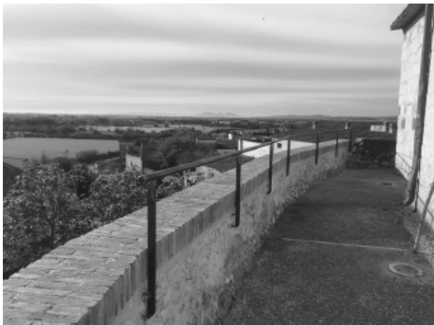
Figura 8. Coronament del tram est després de la intervenció.
