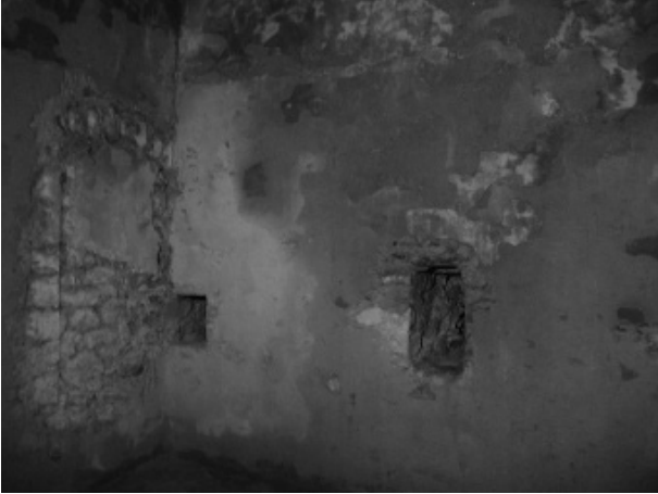
Figura 4. Primer pis: detall d'una finestra paredada i dues espitlleres recuperades.
