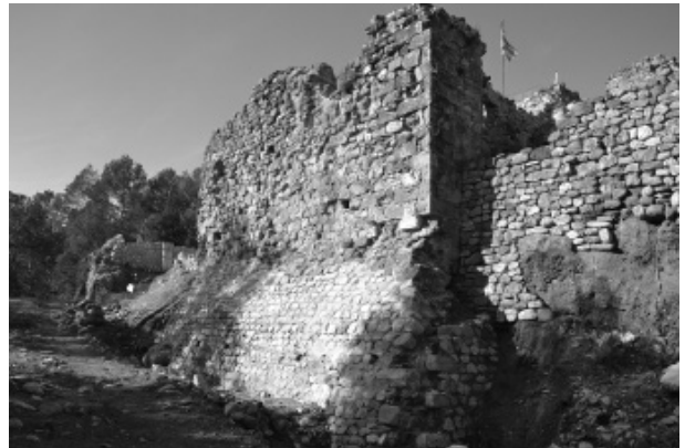
Figura 4. La muralla sud del castell, després dels treballs de consolidació.
