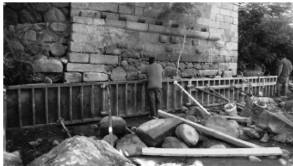
Figura 8. Construcció del nou encofrat de fonamentació.
