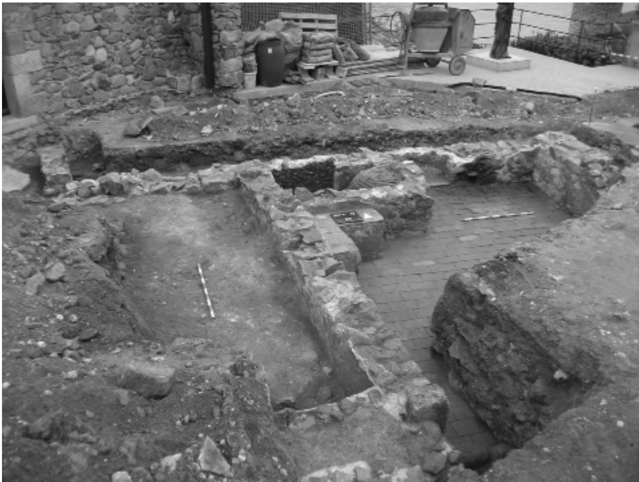
Figura 3. Vista general de la intervenció, des del sud.
