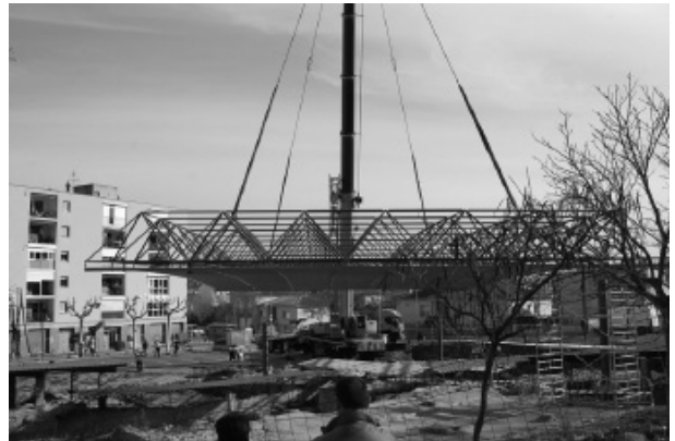
Figura 8. Tasques de col·locació de la coberta al sector sud de la vil·la.
