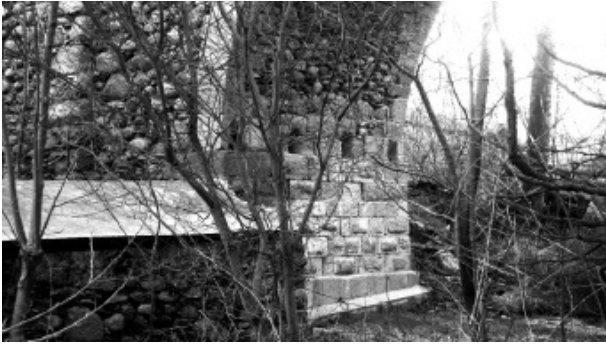
Figura 3. Basament esquerre de l'arc petit (costat de Puigcerdà), on s'observen els carreus encoixinats, també presents en els altres dos basaments del pont. Així mateix, es veu el cobert del safareig que es va construir als anys trenta aproximadament del segle XX, la presència del qual ha provocat la sedimentació sota l'arc petit i la seva anul·lació pel pas del riu.
