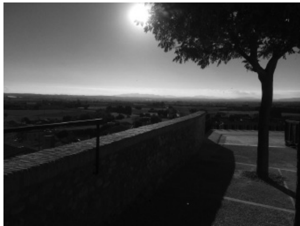
Figura 9. Coronament del tram sud després de la intervenció.
