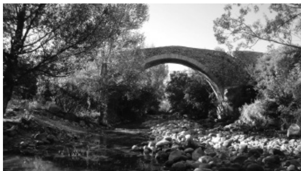
Figura 1. Vista general de la façana nord del pont, en la qual s'aprecia l'arc principal i com l'arc petit queda amagat i anul·lat per la vegetació.
