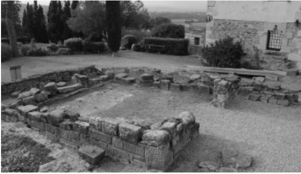
Figura 7. Visió general dels temples A i C abans de l'inici de la intervenció de conservació-restauració.
