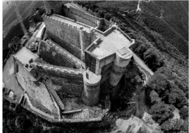
Figura 2. Accés fortificat, barbacana i adarb nord de Montsoriu. Excavació del fossat nord 2016.
