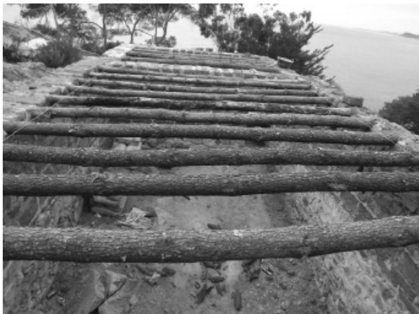
Figura 6. Vista de les bigues col·locades.
