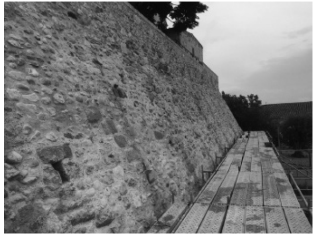
Figura 4. Parament del tram sud després de la intervenció.
