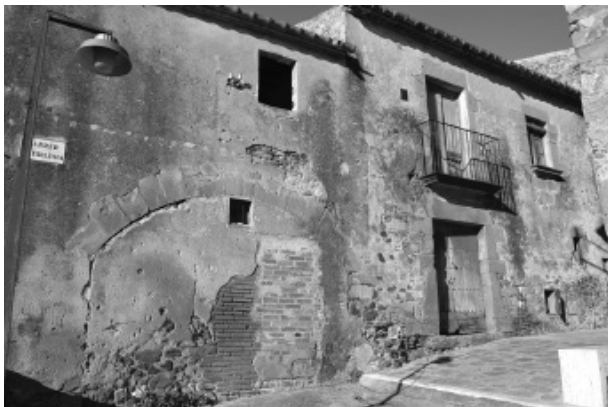
Figura 3. Façana principal de l'edifici. A la part inferior entre els dos cossos es pot veure la muralla medieval.
