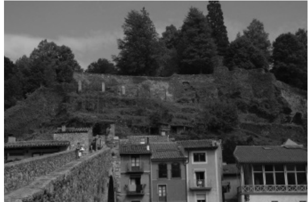
Figura 4. Fotografia de les muralles des del pont Nou.
