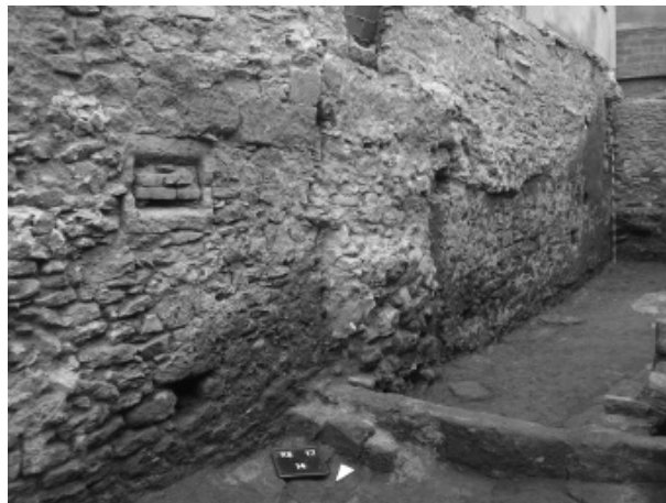
Figura 4. Façana antiga de la Rectoria, deixada al descobert en la nostra intervenció.
