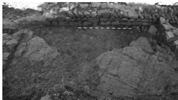
Figura 5. Àmbit 1 de la Zona 6, vist des de llevant. Al fons el mur de llevant de la Sala al que s'adossen aquestes estances. Als costats, els murets que delimiten l'àmbit.
