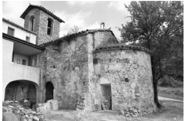
Figura 3. Aspecte del mur de migdia de l'església finalitzada l'obra.
