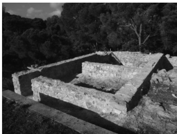
Figura 3. Vista general de la casa, amb el sòcol enllestit.
