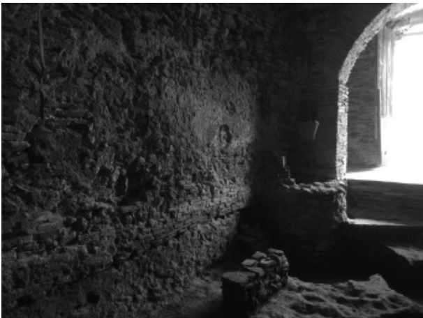
Figura 4. Vista dels paraments interiors, després de la intervenció.
