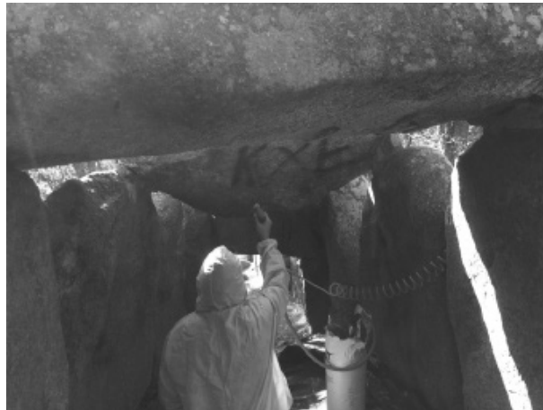
Figura 3. Procés de neteja mitjançant projecció controlada d'abrasius.
