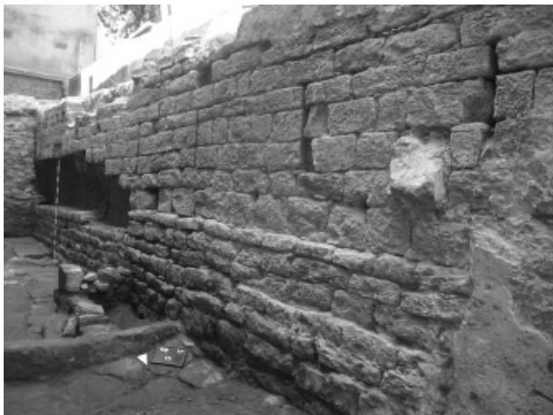
Figura 3. La part antigament exterior de la muralla, deixada al descobert en la nostra intervenció.
