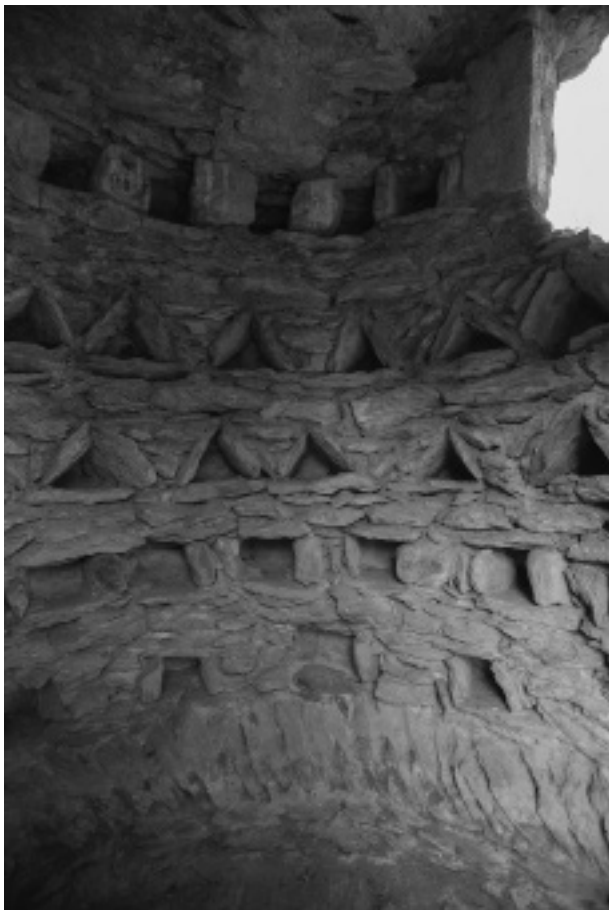
Figura 3. Detall del parament interior del colomar en el que es veuen les filades de nius.
