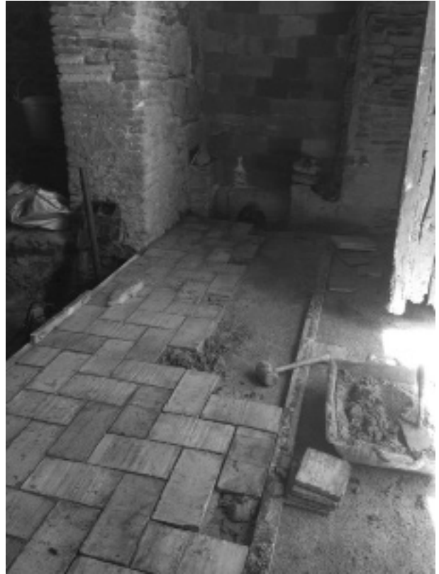
Figura 5. Procés de treball en la zona d'entrada a l'edifici.
