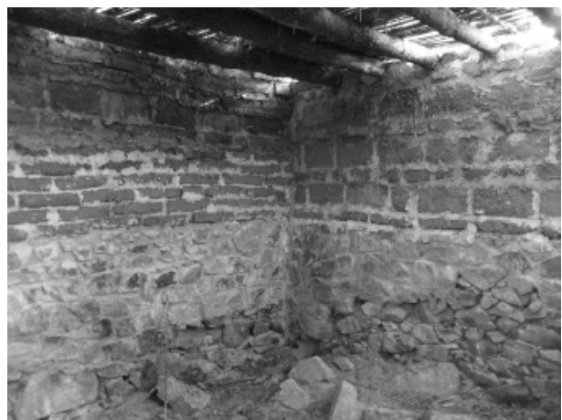
Figura 5. Detall de l'interior de la casa, amb els diferents paraments reconstruïts.
