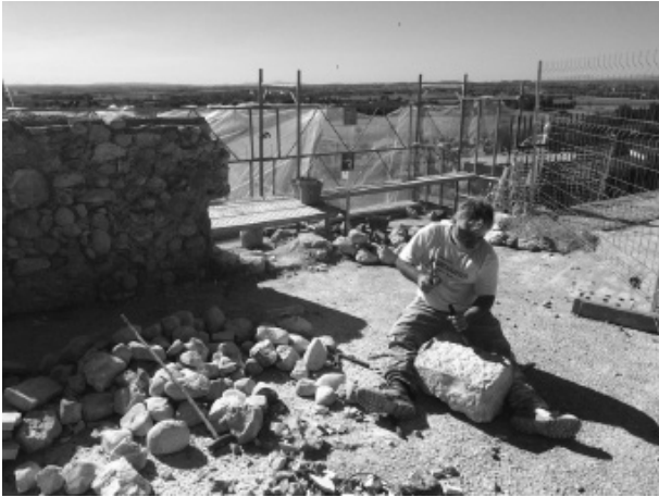
Figura 6. Treballs de reconstrucció del tram sud.
