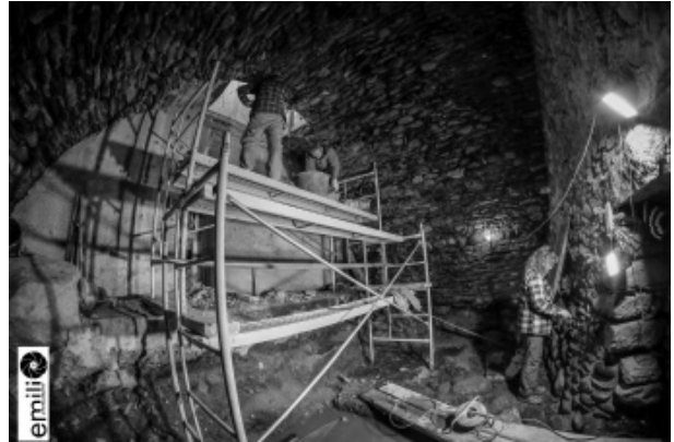
Figura 3. Vista de l'interior de la sala-cisterna durant les tasques d'excavació i adequació (Emili Giménez).
