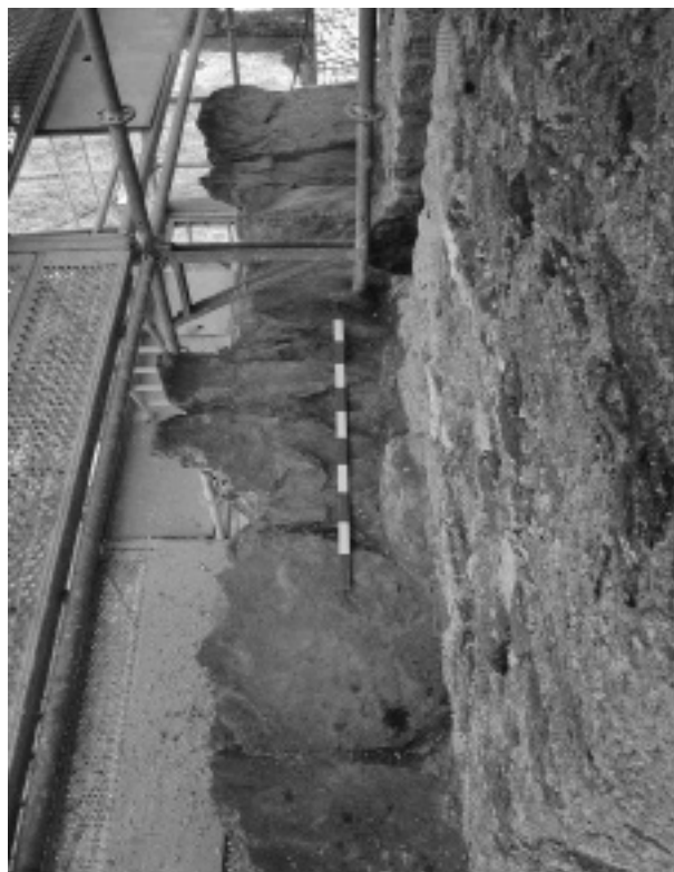
Figura 5. Vista del pas de ronda un cop excavat, des de l'oest. Aquest s'ha conservat a l'alçada del segon pis de la torre.
