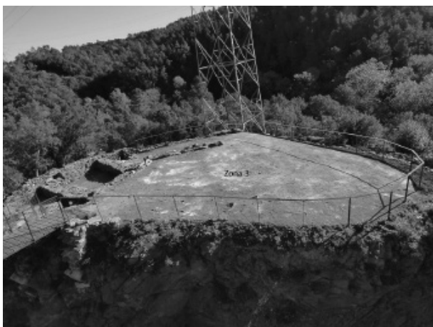
Figura 4. Foto de la zona 3 un cop finalitzats els treballs d'adequació.
