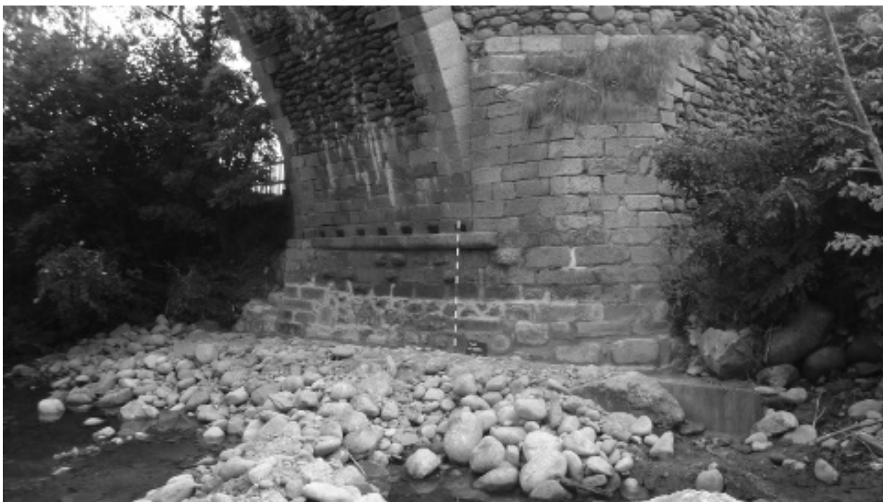
Figura 9. Aspecte del basament després de la reparació de la fonamentació.
