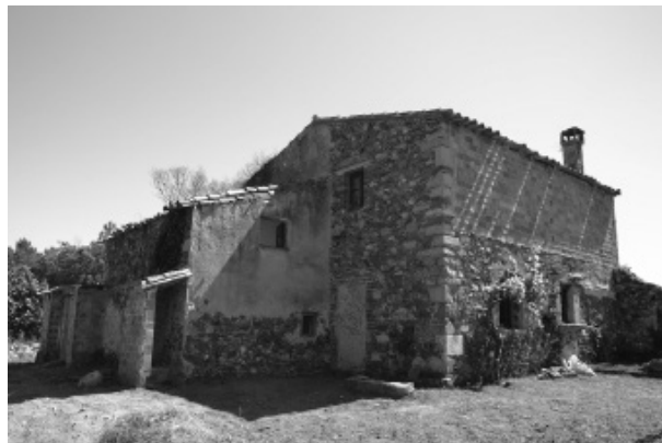
Figura 5. Imatge de l'angle sud-oest de l'edifici.
