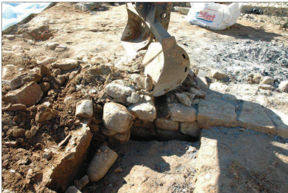
Eliminació parcial dels murs 1004 i 1007
