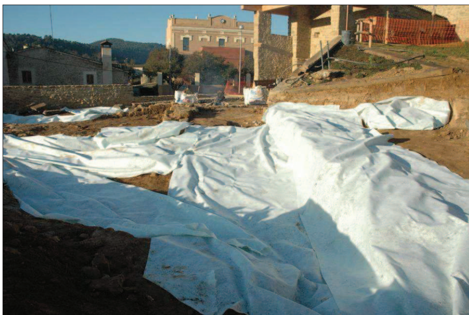
Cobriment de les estructures amb geotèxtil
