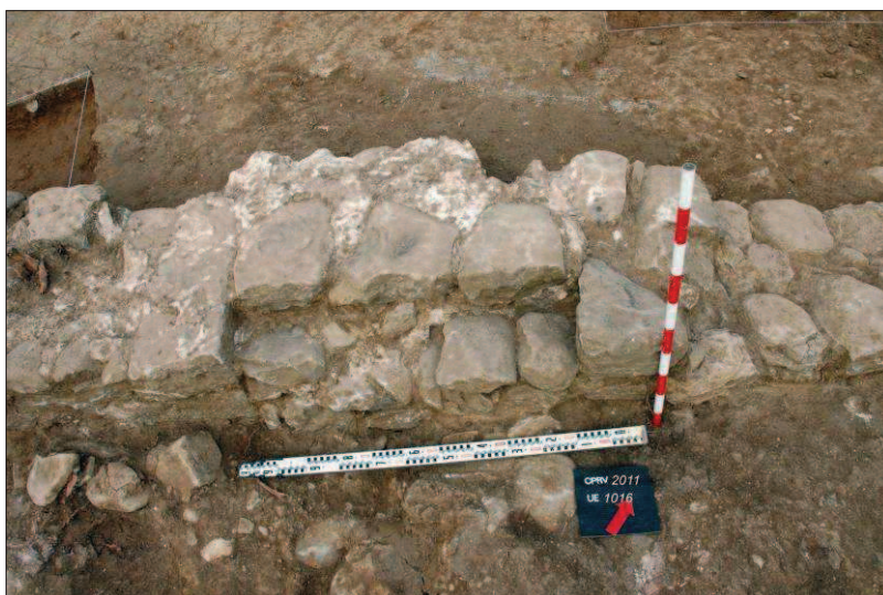
UE 1016 vista des del sud
