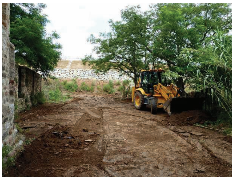
SANT PAU DE RIU- SEC (Sabadell, Vallès Occ.) 2011.- Vista dels treballs de prospecció i retirada del nivell superior vegetal al sector 9, darrere l'absis.
