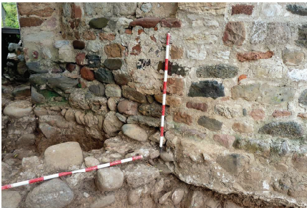
SANT PAU DE RIU-SEC (Sabadell, Vallès Occ.) 2011.- Detall del mur UE 1230 i el fonament de l'església romànica UE 1234 que s'hi assenta.
