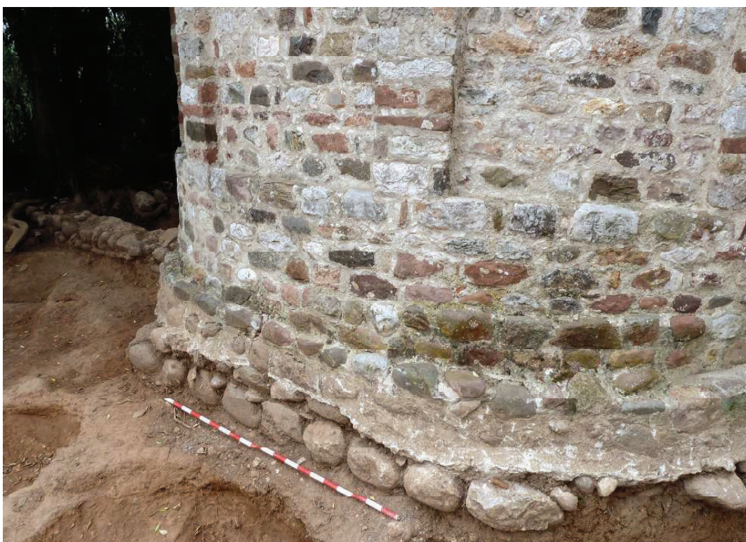
SANT PAU DE RIU-SEC (Sabadell, Vallès Occ.) 2011.- Detall de la part frontal del mur UE 1230, de planta trapezoïdal fent exedra, que es troba sota la fonamentació semicircular de l'absis de l'església romànica.
