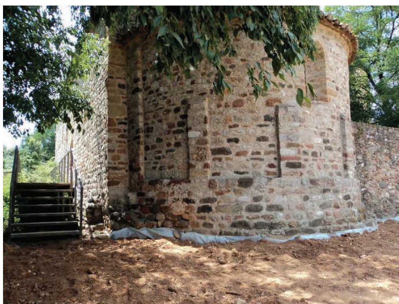
SANT PAU DE RIU-SEC (Sabadell, Vallès Occ.) 2011.- Vista del procés de cobriment de l'absis i els murs romans documentats en el sector 9. Aquests han estat recoberts amb geotèxtil primer, i després amb una capa de terres.
