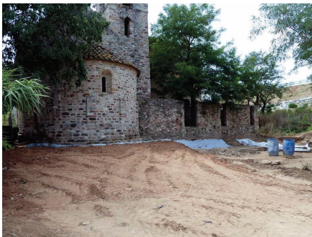
SANT PAU DE RIU-SEC (Sabadell, Vallès Occ.) 2011.- Vista dels treballs de cobriment de tot el sector 9, amb geotèxtil i una capa de terra fins a assolir la cota original del sector.
