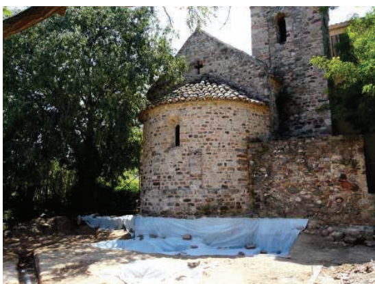
Vista del sector 9 durant els treballs de cobriment de les estructures arqueològiques amb geotèxtil.
