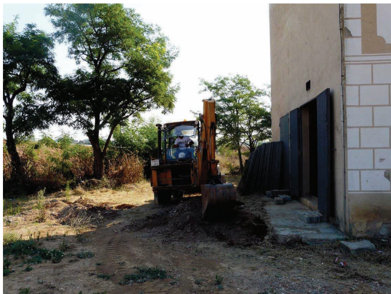
SANT PAU DE RIU-SEC (Sabadell, Vallès Occ.) 2010.- Vista del Sector 1 durant els treballs de retirada de l'estrat superficial amb excavadora de pala plana.
