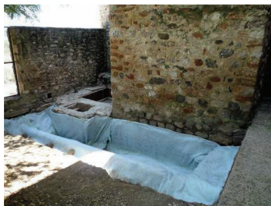
Vista del sector 10 durant els treballs de cobriment de les estructures arqueològiques amb geotèxtil.
