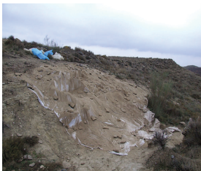
Fig. 34. Imatges del cobriment amb geotèxtil i terra per sobre d'aquest.
