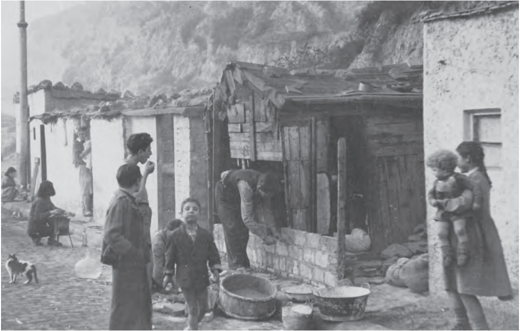
Home construint una nova barraca de totxo que ha de substituir la de fusta. Barraques del Morrot de Montjuïc. Font: TRIÁS BERTRÁN, Carlos (1949). «Las barracas ante el problema de la vivienda». Barcelona: Ajuntament de Barcelona, Arxiu Municipal Administratiu.
