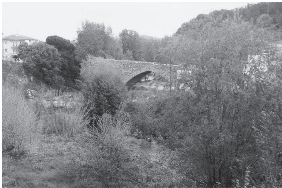
El Pont Trencat (Sant Celoni). Foto MEMGA
