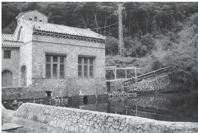
Bassa i edifici de la Central Elèctrica de Dalt (Gualba). Foto IPEC
