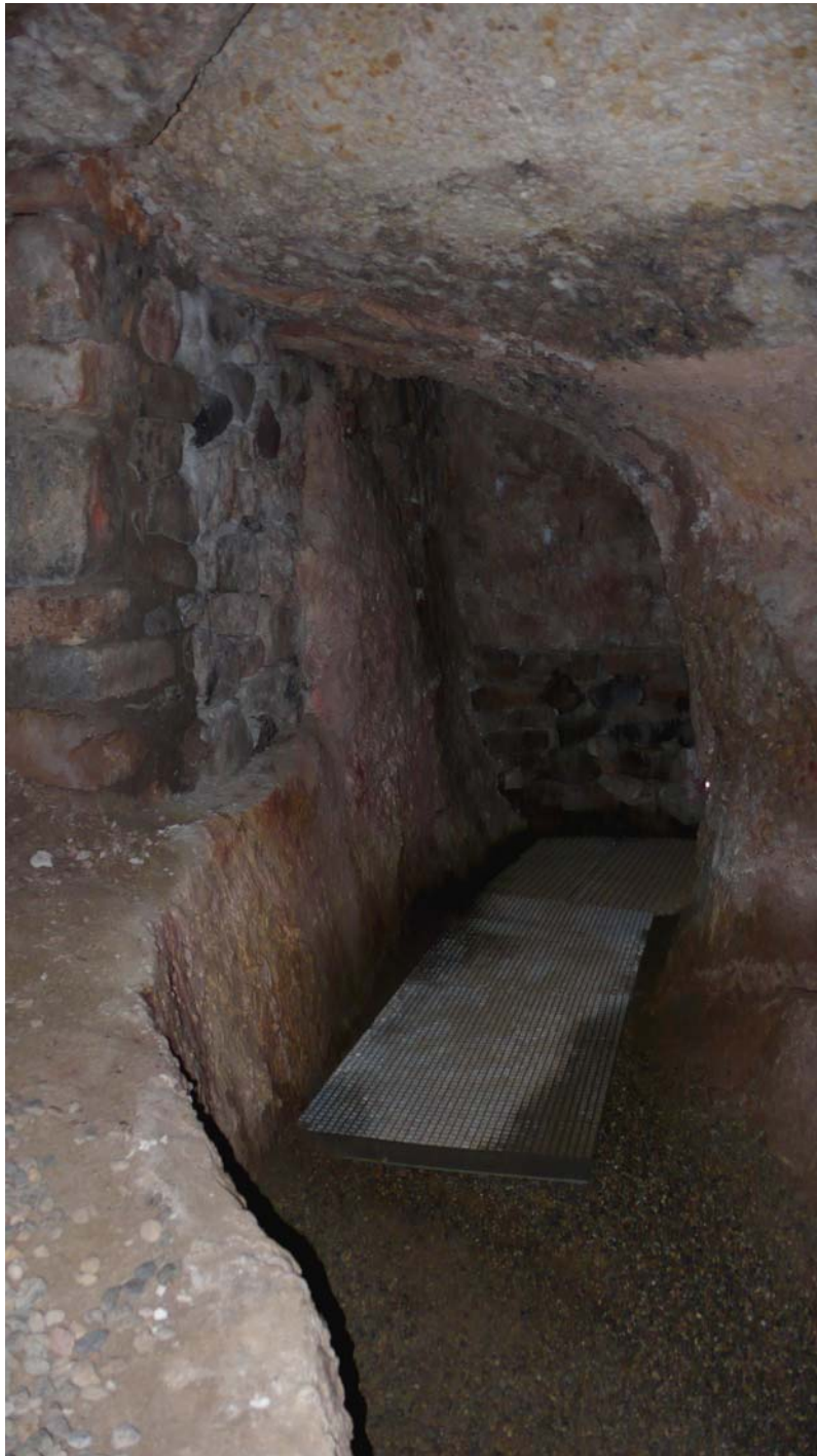
Figura 13.- Vista general des de la cova de la Font Major una vegada efectuades les tasques de protecció de les seccions.
