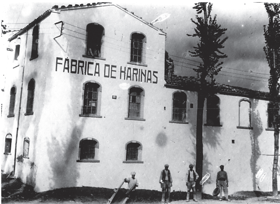
■ Associació Cultural "Baixa Segarra". Autor Cortàzar?. "Farinera de la Muralla", fàbrica de farina situada al passeig de la Muralla de Santa Coloma de Queralt". Santa Coloma de Queralt (Conca de Barberà), 1920-1930
