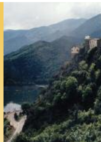
Vista general del roc sobre el pantano d'Oliana
