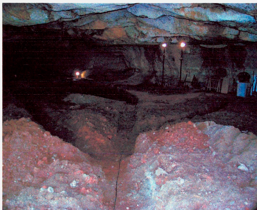
Figura 4. Rases realitzades per a la instal·lació de les canonades del circuit tancat d'aigua i sistema de drenatge de la cascada artificial.
