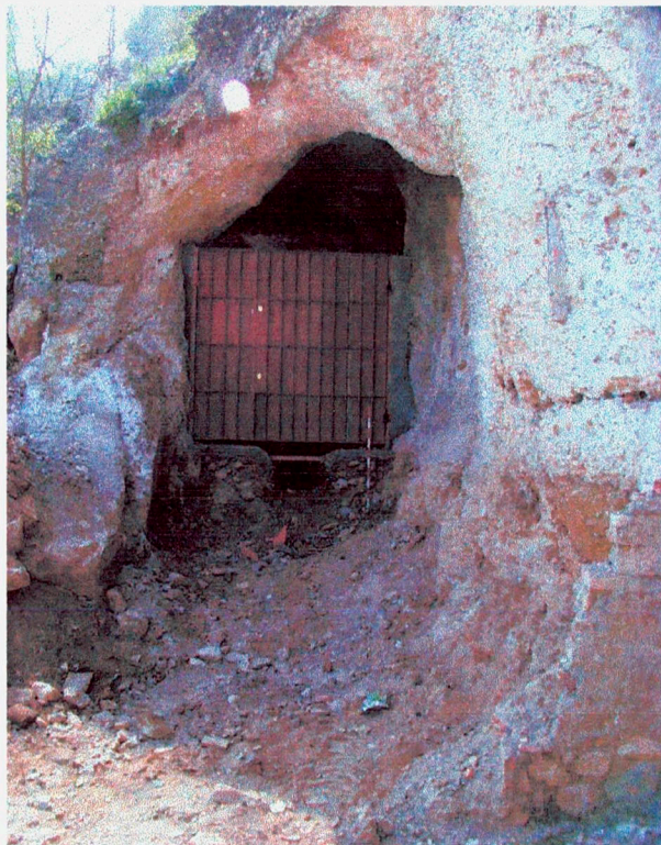
Figura 6. Aspecte de la boca nord un cop eliminat el moll de càrrega.
