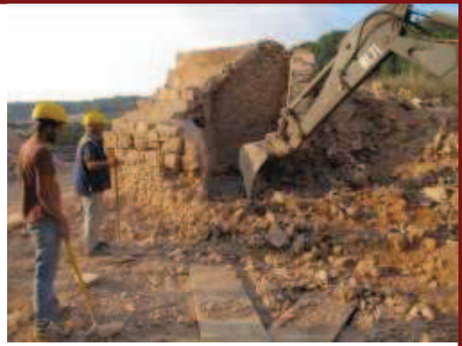
Enderrocament de les estructures muraries afectades objecte d'enderrocament.
