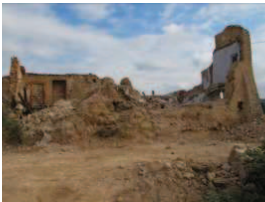
Façana de ponent del conjunt edificat
