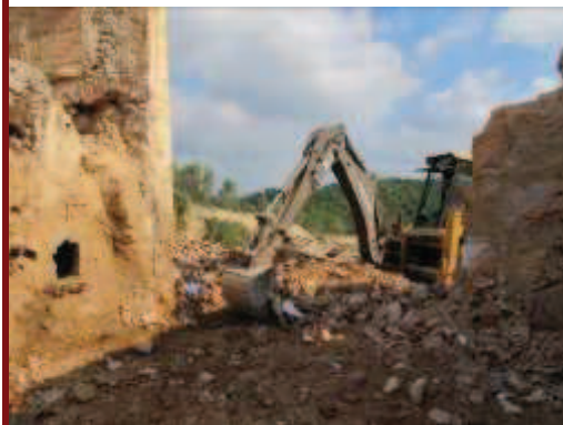
Retirada de les runes acumulades una vegada seleccionat el material.
