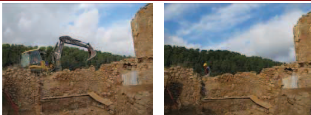
Imatges que il·lustren les pautes d'alternança dels mitjans mecànics i els manuals emprats en les tasques d'enderroc d'una de les estructures afectades pel projecte constructiu.
