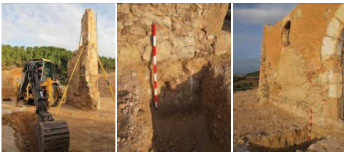
Seqüència gràfica d'imatges que il·lustren l'abast i entitat dels treballs d'obertura i excavació de les rases projectades per la construcció de les sabates de fonamentació.
