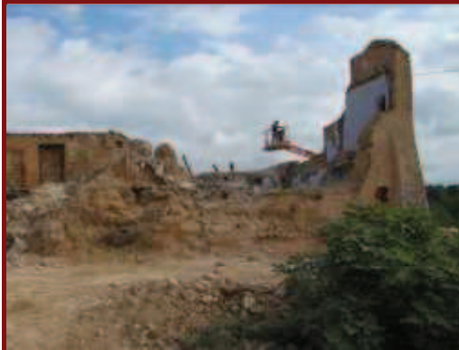
Enderrocament selectiu d'estructures i preservació d'elements seleccionats.
