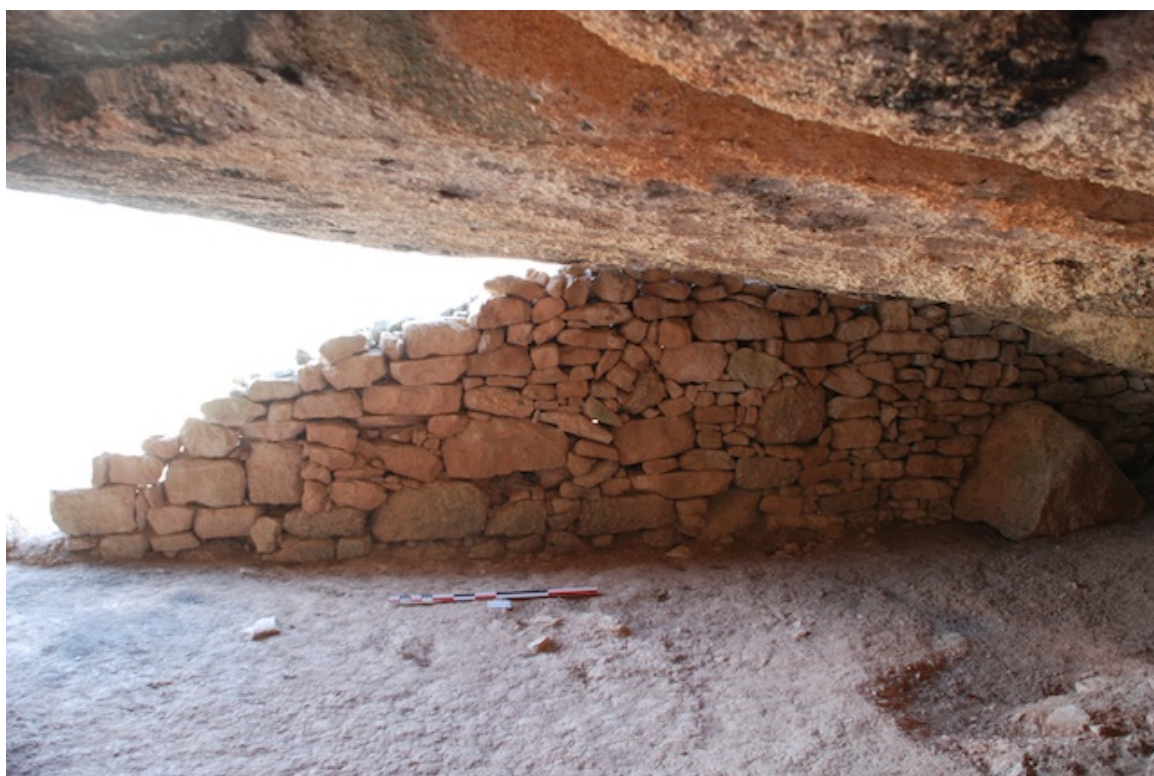
Figura 3. Vista des l'interior del mur MR-3 on s'aprecia l'adequació als fragments de visera caiguda.
