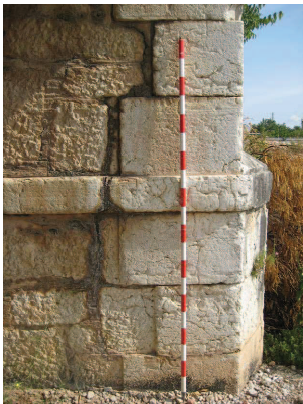
Vista d'un pilar central on es pot apreciar el conjunt de la composició estructural de les parts que l'integren així com el detall de la cornisa decorativa que dona unitat compositiva i formal al conjunt del cos central del pont.
