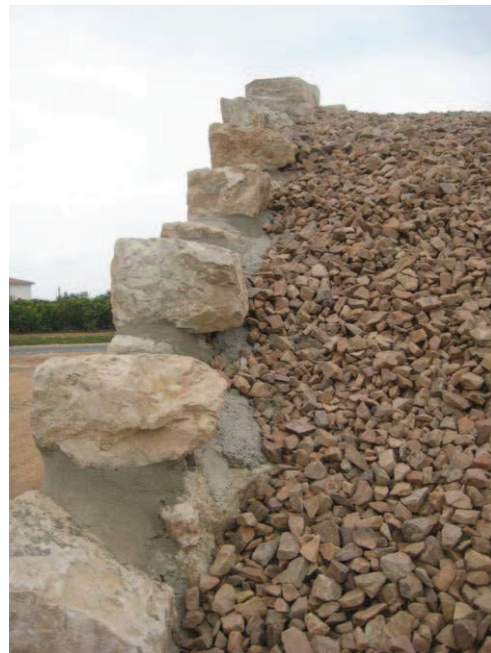
Detall de l'acabat dels interiors dels estrep de l'obra nova del pont on es pot apreciar la disposició de la capa de balast que s'ha aplicat per reforçar la idea de la superfície que originalment es disposava a les vies per col·locar-hi els rails.
