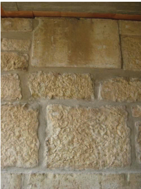
Detall d'un tram del parament de carreus refet de l'interior de la pas central de l'antic pont, on es pot apreciar la cura que s'ha tingut en preservar l'aparença original d'aquesta estructura.
