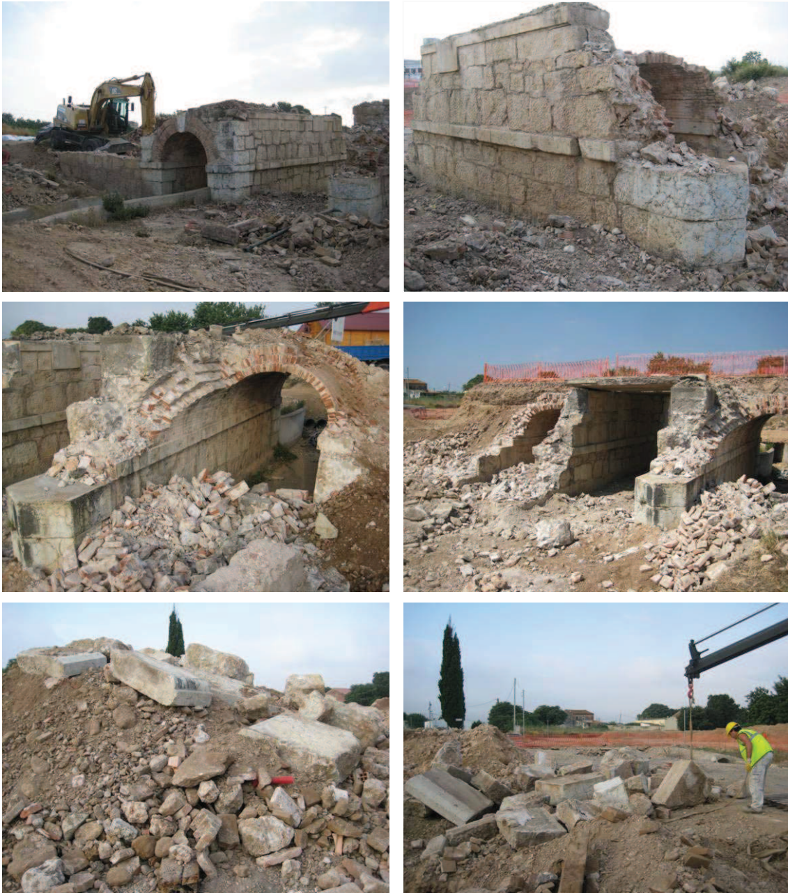
Diverses imatges que il·lustren diversos moments del procés de desmuntatge de l'antiga estructura del pont del ferrocarril així com de les tasques d'identificació i recuperació dels materials petris que han de ser reconstruïts, en el nou emplaçament del pont.
