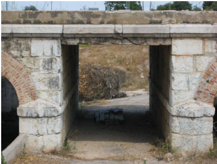
Detall de l'obertura central de la cara oest del pont on es pot apreciar el detall compositiu d'aquesta estructura fent-se evident la incidència visual que sobre l'obra original que tingué la caixa de les conduccions d'època contemporània.
