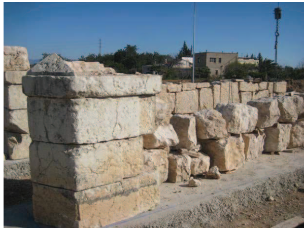
Imatge del pilar central amb el característic trencaaigües de planta triangular.
