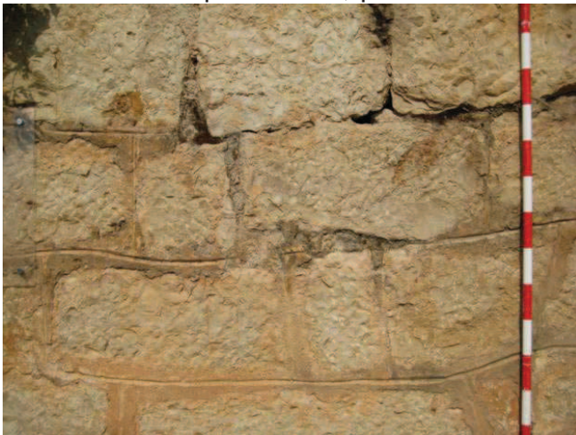
Detall del cisellat original del rejuntat del parament de les cares exteriors dels murs dels estreps.
