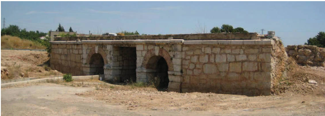
Vista panoràmica del conjunt de les estructures del pont ferroviari una vegada es va realitzar la retirada de sediments que amagaven el parament de l'alçat de l'obra de fàbrica original l'element.
