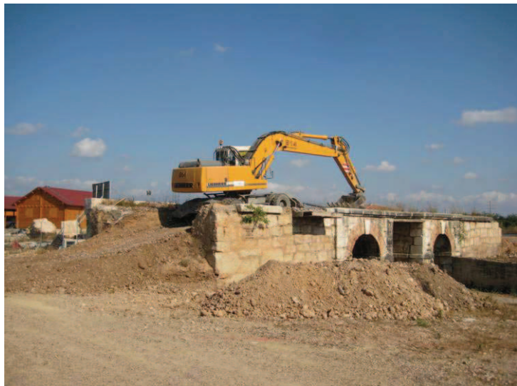
Imatge que recull el inici dels treballs de desmuntatge, amb mitjans mecànics, del conjunt de les estructures de l'antic pont del ferrocarril.
