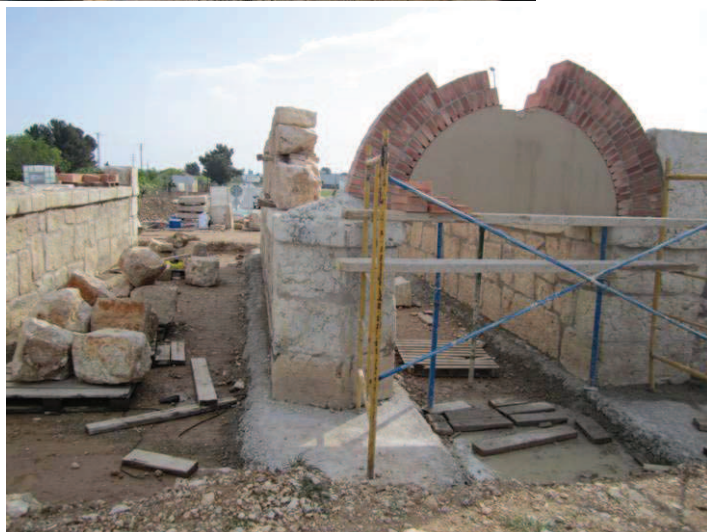
Construcció de la volta de mig punt de maons que cobreix el dos ulls laterals de l'estructura del pont.
