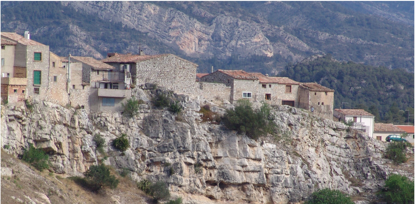
Vista de les cases Penjades abans de realitzar-se les obres a una de les cases.
