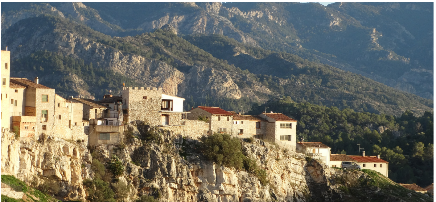
Després de les obres ha canviat la silueta de les cases penjades.
