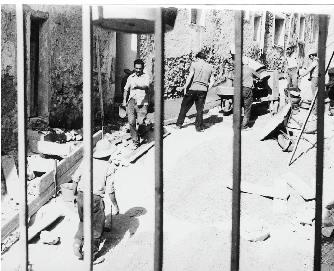
Els veïns del carrer de la Graella pavimenten el carrer.
