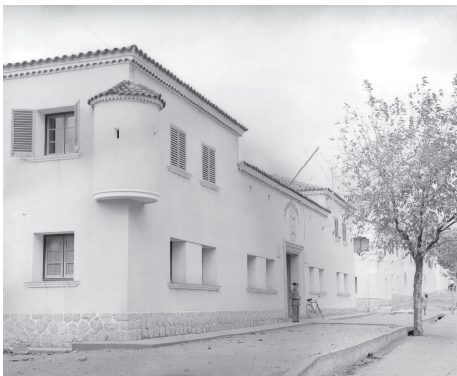
La caserna de la Guàrdia Civil després de la seua construcció per Regiones Devastadas els anys quaranta.
