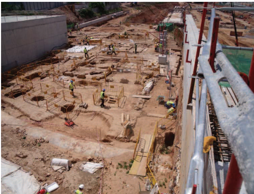
Procés d'excavació en el sector Estructura.
