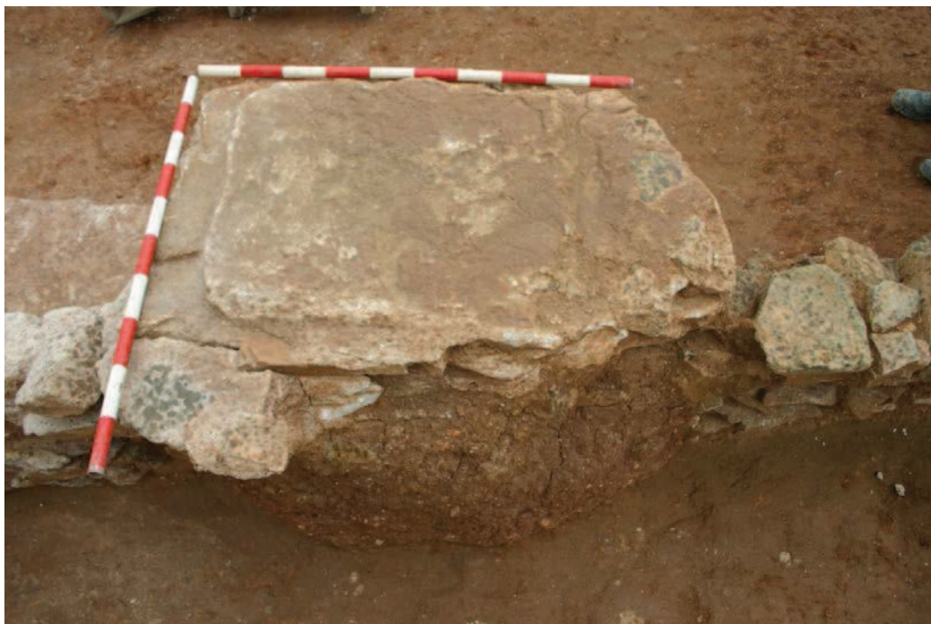
Detall de la fonamentació d'una basament (UE 7019) ja espoliat. Es pot apreciar la fonamentació de maçoneria i morter amb l'empremta del carreu que suportaria la columna.
