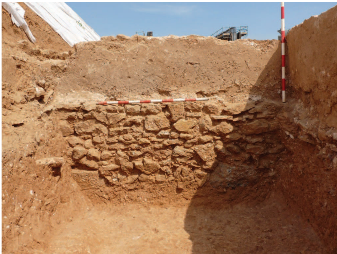
Detall de la fonamentació i el mur que delimita la bateria d'habitacions pel seu costat nord.
