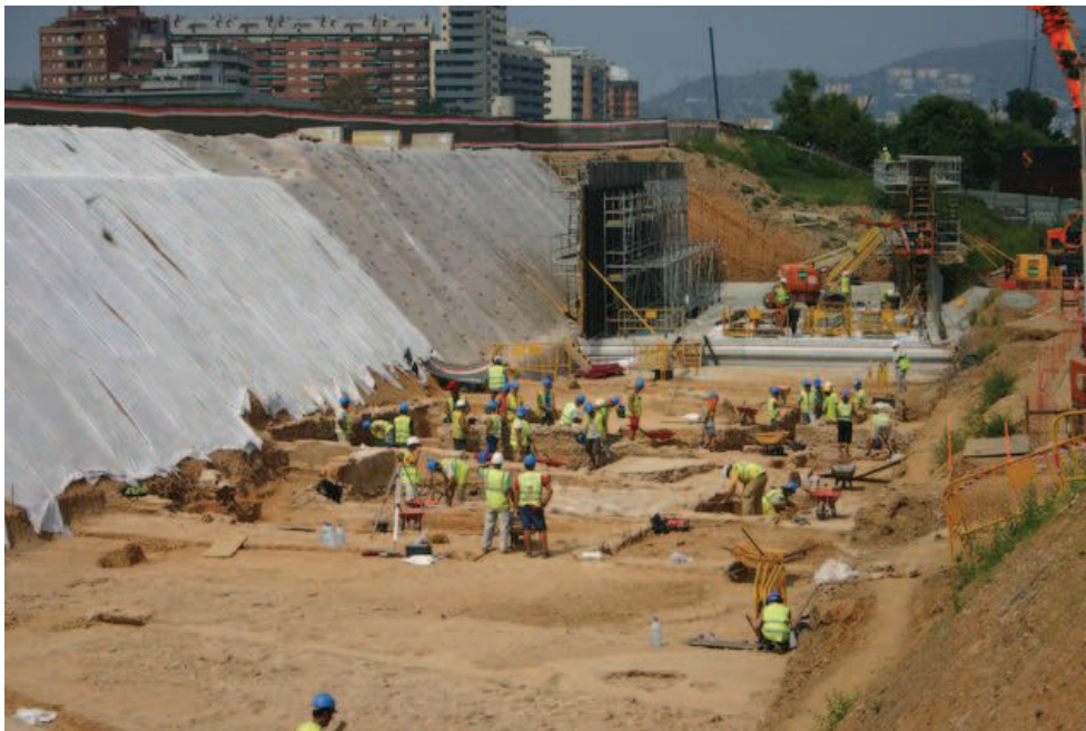
Procés d'excavació en el sector Accessos.
