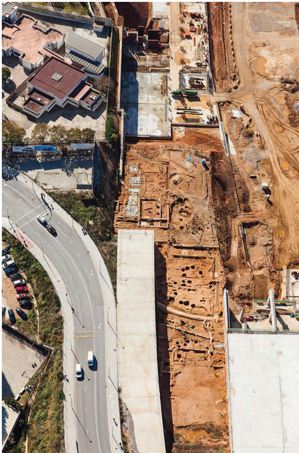
Vista aèria de part de la vil·la en el sector Excavat d'estructura de l'estació. A l'esquerra es veu el túnel del vial segregat, àrea que es va intervenir a l'any 2011
