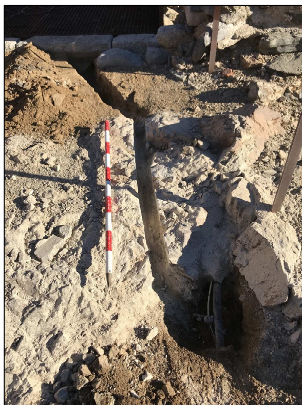
Figura 9. Aspecte de la rasa en direcció est (extrem oest de la passera-fossat)
