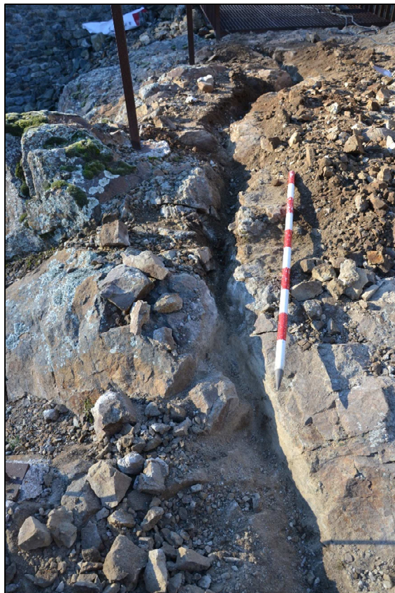
Figura 8. Aspecte de la rasa en direcció oest (extrem est de la passera-fossat)
