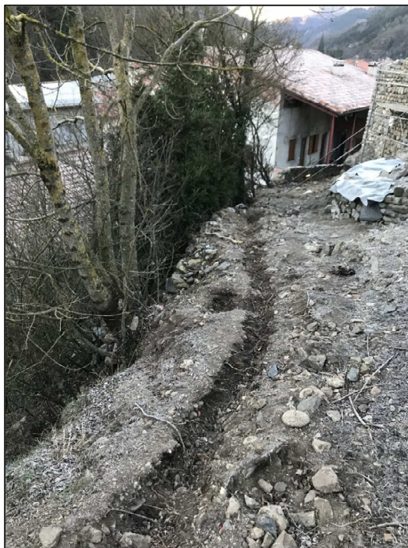
Figura 11. Imatge de la rasa est-oest ja excavada en el moment de la intervenció (recorregut camí)
