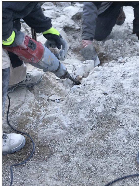
Figura 7. Els treballs s'han fet manualment amb l'ajuda d'un martell hidràulic
