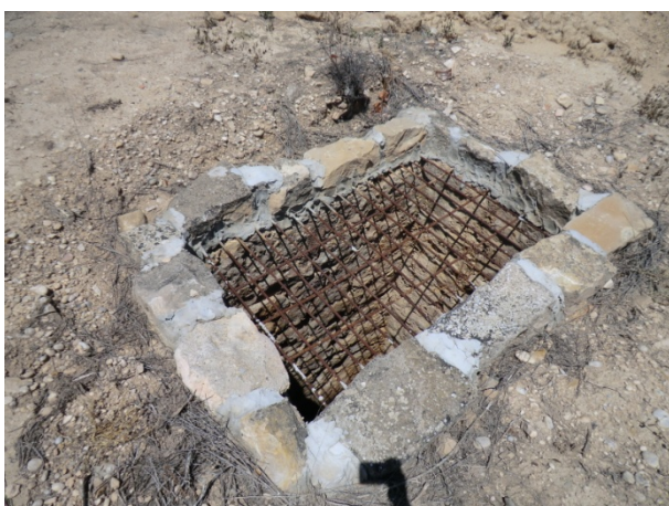
3. Boca del pou de pedra seca, amb una mina lateral a la part baixa del mateix, emplaçada en el pati de la construcció anterior (PI-31).
