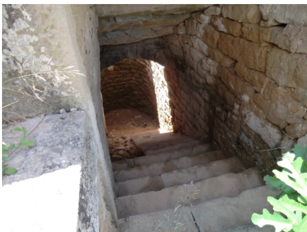
5. Escales que baixen al fons del pou. Es pot observar la fantàstica obra en pedra seca, tant en les parets, com en la volta que les cobreixen (PI-12).
