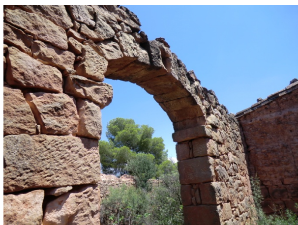
4. Una de les arcades que separa la zona coberta de la descoberta. El sostre es troba esfondrat (PI-21).
