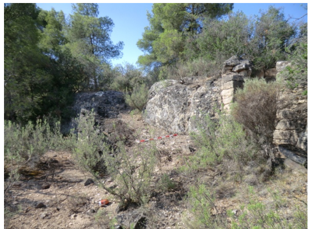
6. Entrada de la cabana i rampa d'accés a aquesta (on hi ha el jaló), en part excavada a la roca i en part construïda amb una paret de pedra seca (PI-1).
