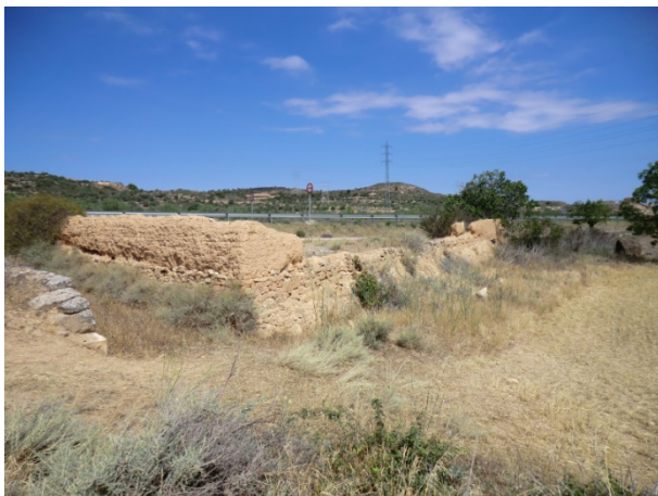
1. Tancat bastit de tàpia, sobre un fonament de pedra seca (PI-3).
