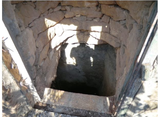
2. Vista de l'interior de l'aljub. Pot observar-se que en bona part està excavat a la roca (PI-1).
