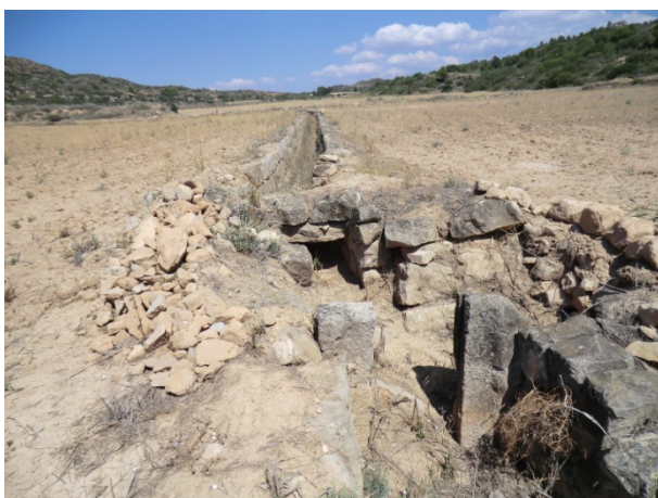
5. Canal amb parets i fons en pedra seca en el qual s'observa, a primer terme, una comporta, i un petit pont més endavant. Entre aquest, a la dreta de la imatge, s'iniciaria un ramal d'aquest canal (PI-29).
