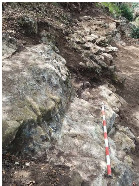
Figura 6. Mur de tancament del conjunt que circula de cingle a cingle. En primer terme es pot observar el treball de la roca per assentar la primera filada (Autoria: M. Sancho)
