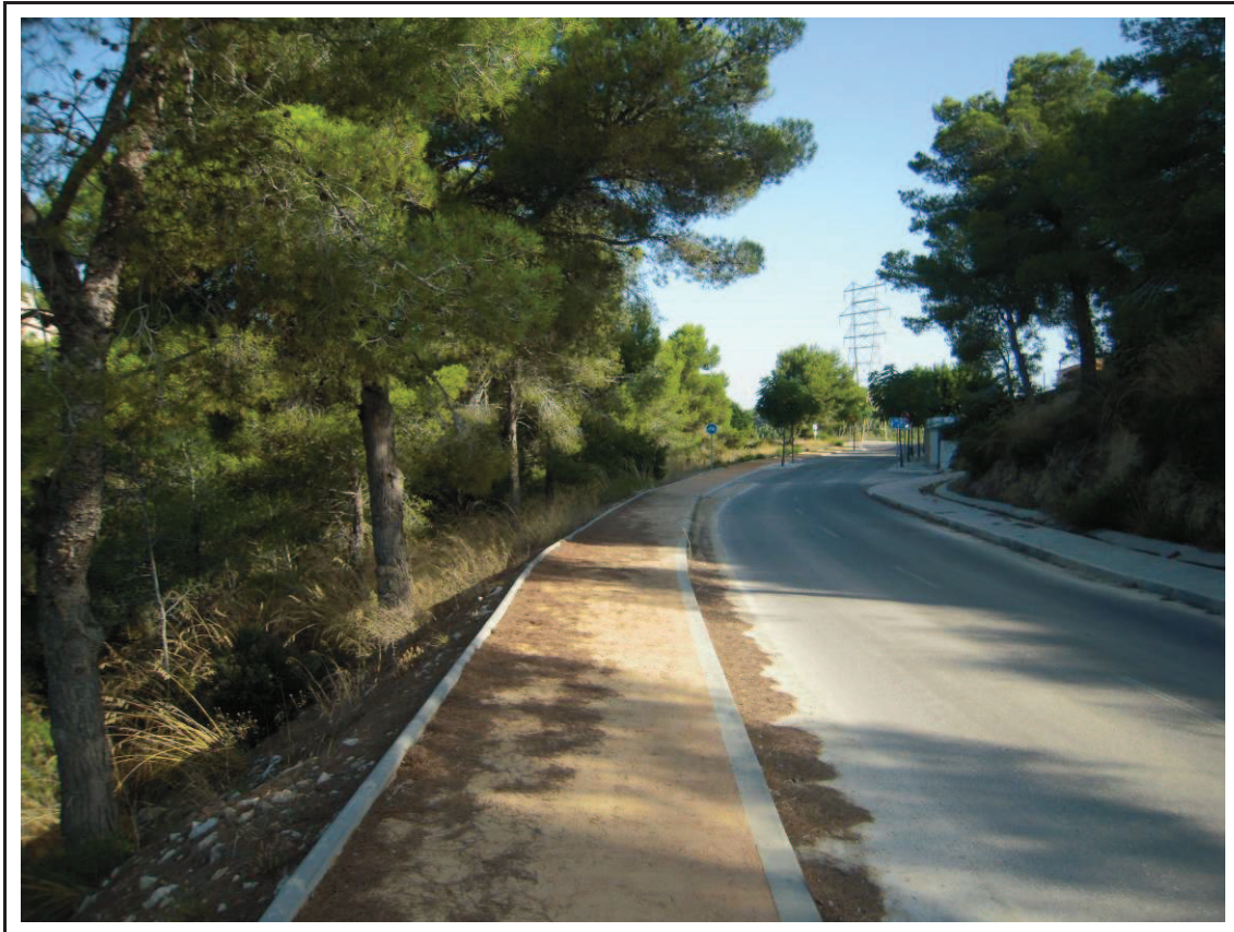
Foto 3: AP 1, inici de la línia subterrània mitja tensió, al carrer del Margalló a la urbanització Can Pere de la Plana.
