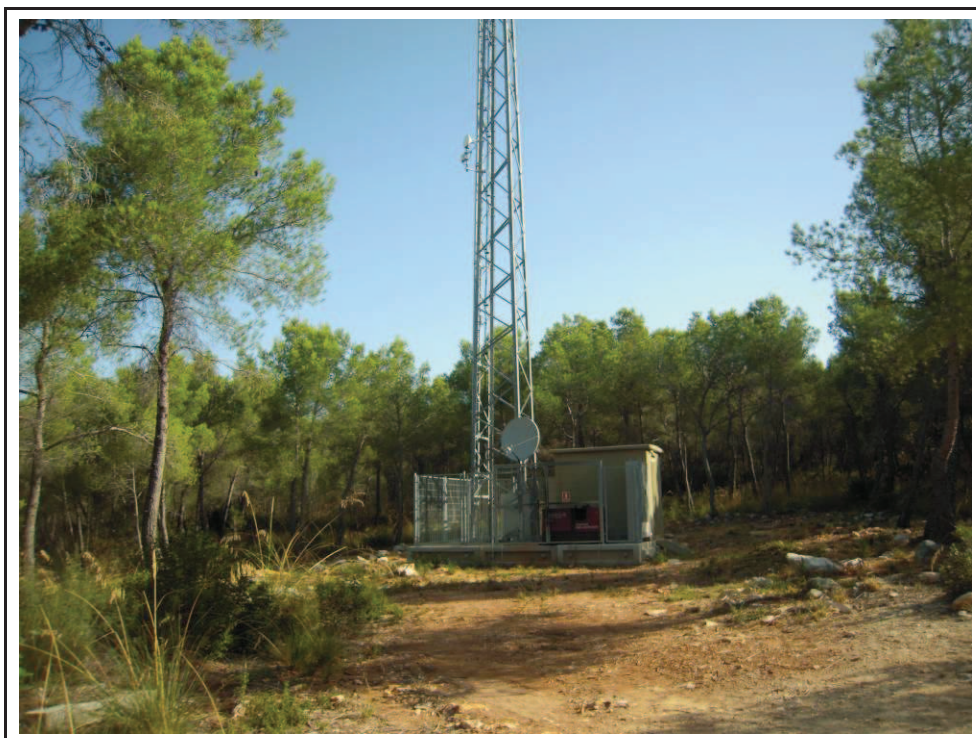
Foto 25: AP 2, final de la línia subterrània de baixa tensió on s'instal·larà una nova antena de telecomunicacions.
