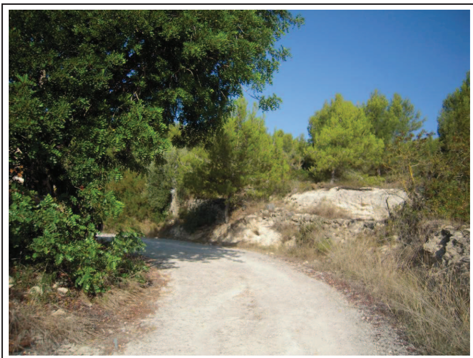
Foto 7: AP 1, detall del vial i talús on aflora la roca calcària.
