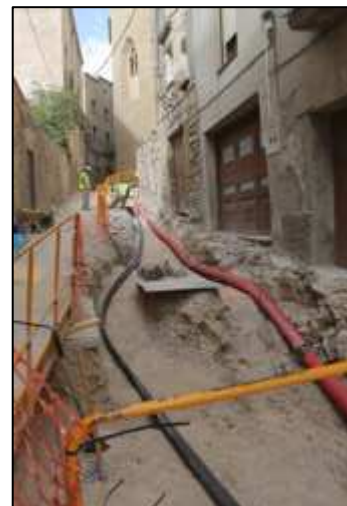
Foto 8. Instal·lació soterrada dels serveis al carrer Sant Domènec
