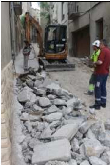
Foto 1. Demolició del paviment al carrer St. Domènec
