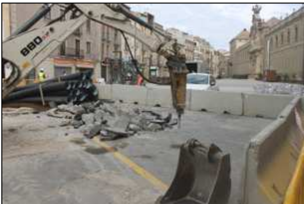
Foto 3. Demolició del paviment a la Plaça Sant Miquel
