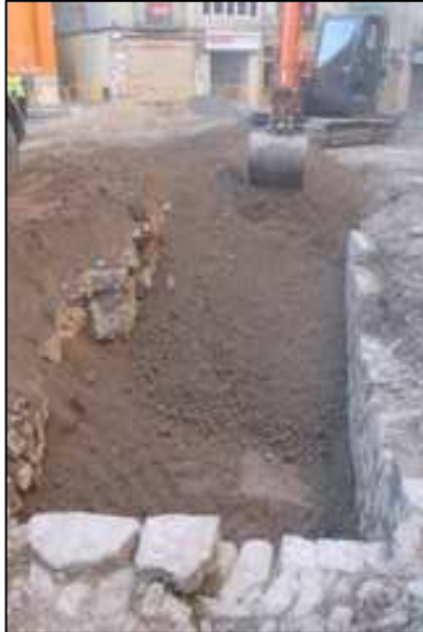
Cobriment i desmuntatge parcial dels murs del celler
