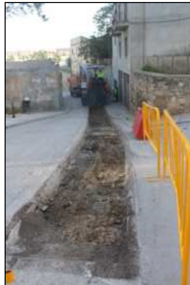
Foto 2. Demolició del paviment al carrer St. Magí
