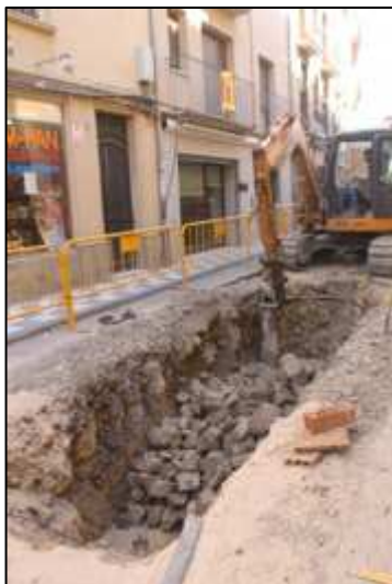
Fotos 6 i 7. Excavació de la xarxa de clavegueram del carrer General Güell i la Plaça Sant Miquel
