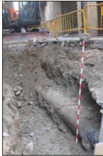
Fotos 4 i 5. Excavació de la xarxa de clavegueram dels carrers Sant Domènec i Santa Anna
