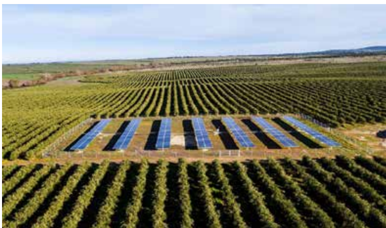
Figura 10. Sistema híbrid (plaques fotovoltaiques i gasoil) d'irrigació instal·lat a Alter do Chao (Alentejo, Portugal). Font: G. Todde et al. (2019): «Energy and environmental performances of hybrid photovoltaic irrigation systems in Mediterranean intensive and super-intensive olive orchards». Science of the Total Environment , 651, pàg. 2.514-2.523.
