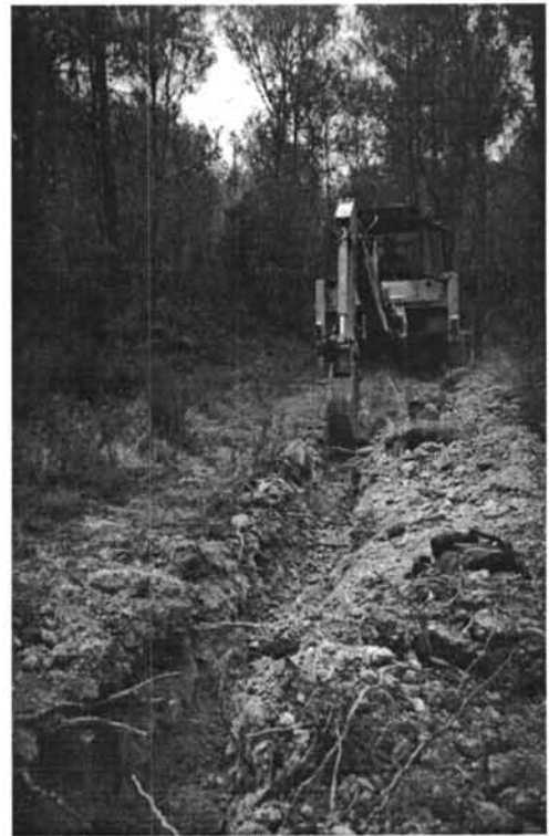
Núm.2.- Vista de la màquina treballant
