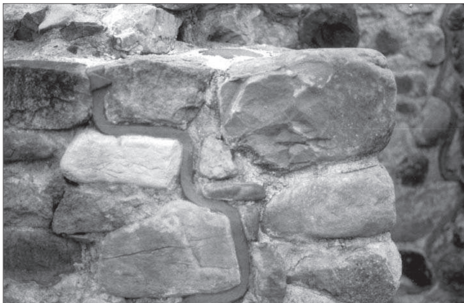
Foto 1. Vil·la romana de Can Terrés. Edifici dels banys. Detall d'una cinta de morter tenyit amb un triangle que indica la zona reintegrada.
