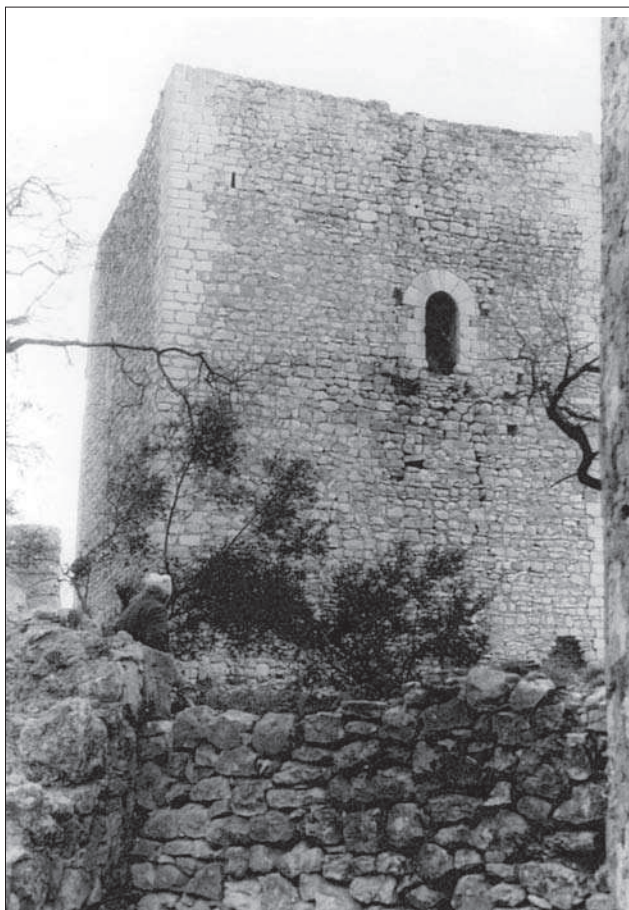
Detall de la torre quadrada (D).
