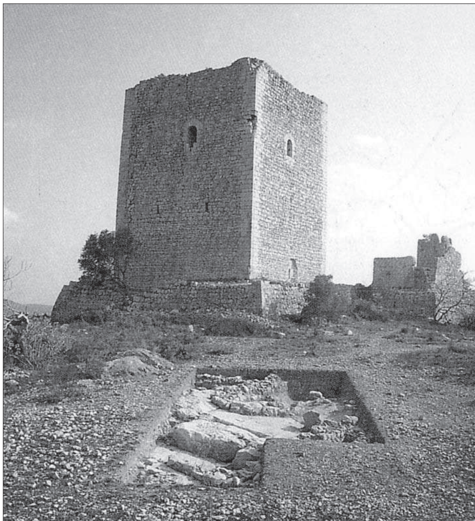
Detall de l'àrea excavada durant la primera etapa d'intervencions
