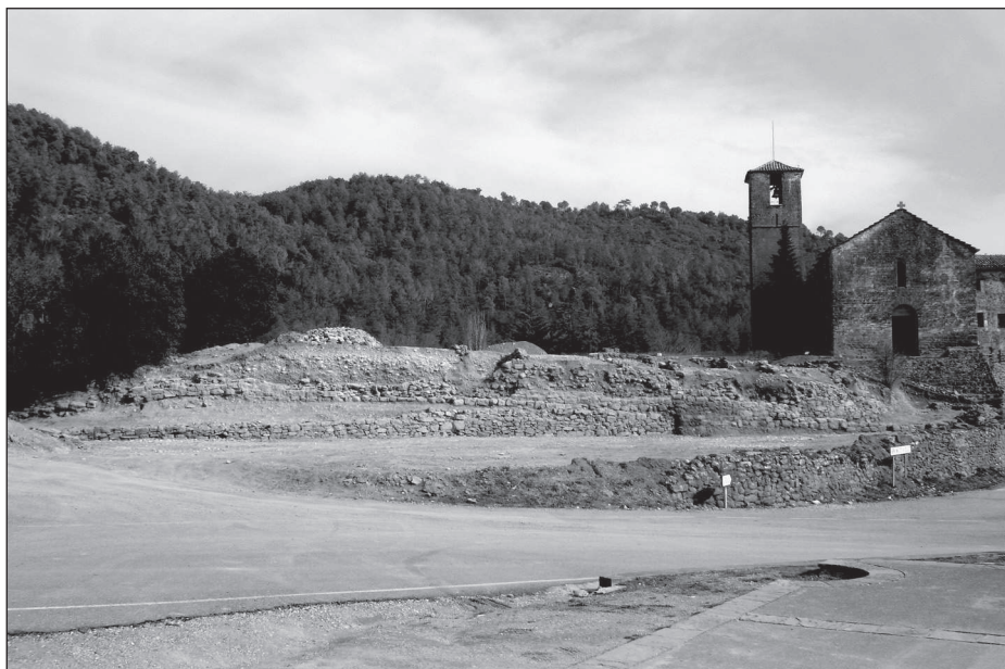
Figura 3. Vista frontal de la muralla o mur de tanca de l'assentament ibèric.
